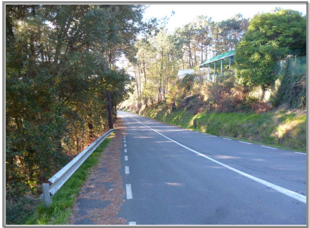
Vista general de la zona en la carretera a ampliar CP-5702
