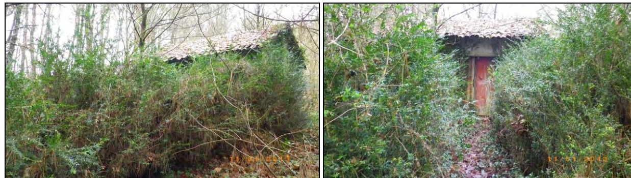
F20-21: construcción en el P.K. 0+200 del eje 1 de la alternativa 2.
