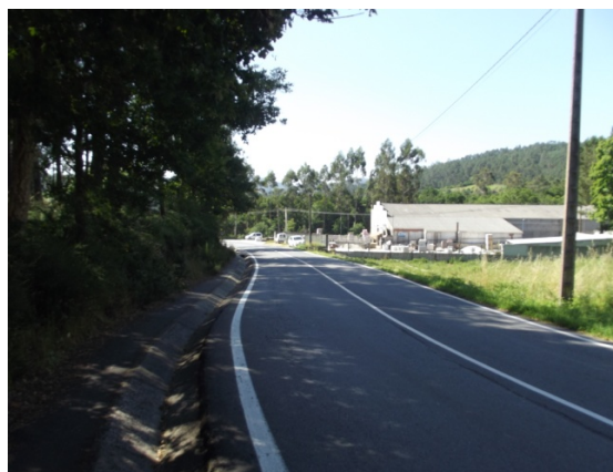
Desde rotonda entre eje 1B y eje 3 hacia Eje 3.
