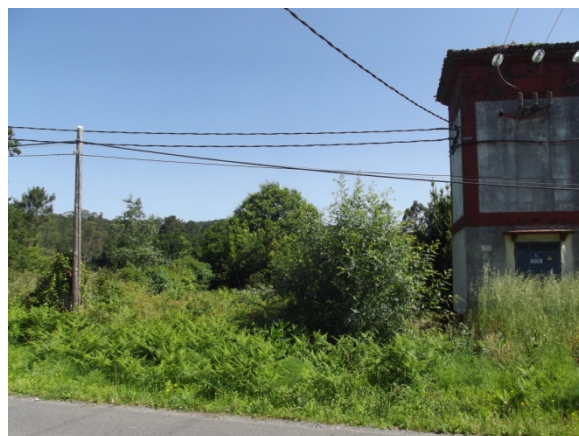
Foto PK 0+ 576 hacia inicio.
