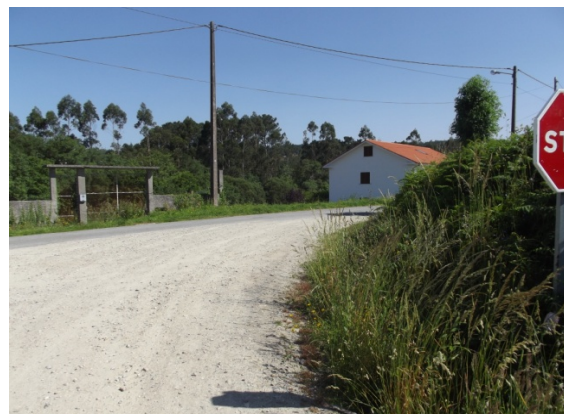
Desde PK. 0+260 hacia inicio (Eje 3).
