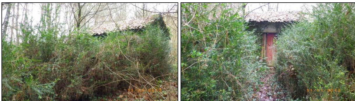
F16-17: Construcción en el P.K. 0+220 del eje 3
