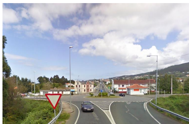
Foto 1: vista de la glorieta donde se inicia el tramo considerado, situada en la intersección con la AC-116
