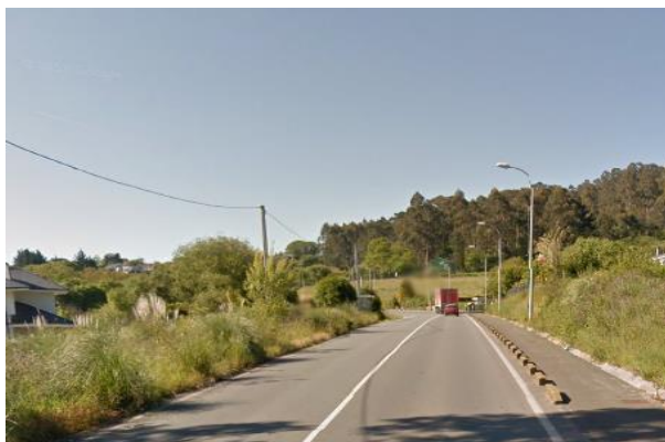
Foto 4: en la parte final del trazado hay una senda peatonal adosada a la margen derecha
