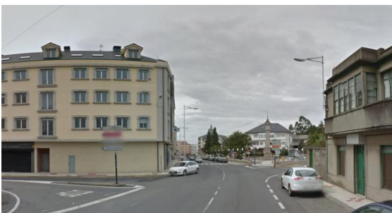
Foto 7: Tramo en A Laracha
