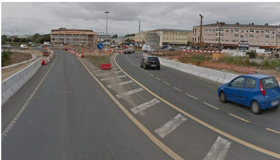
Foto 4: Final del tramo.
