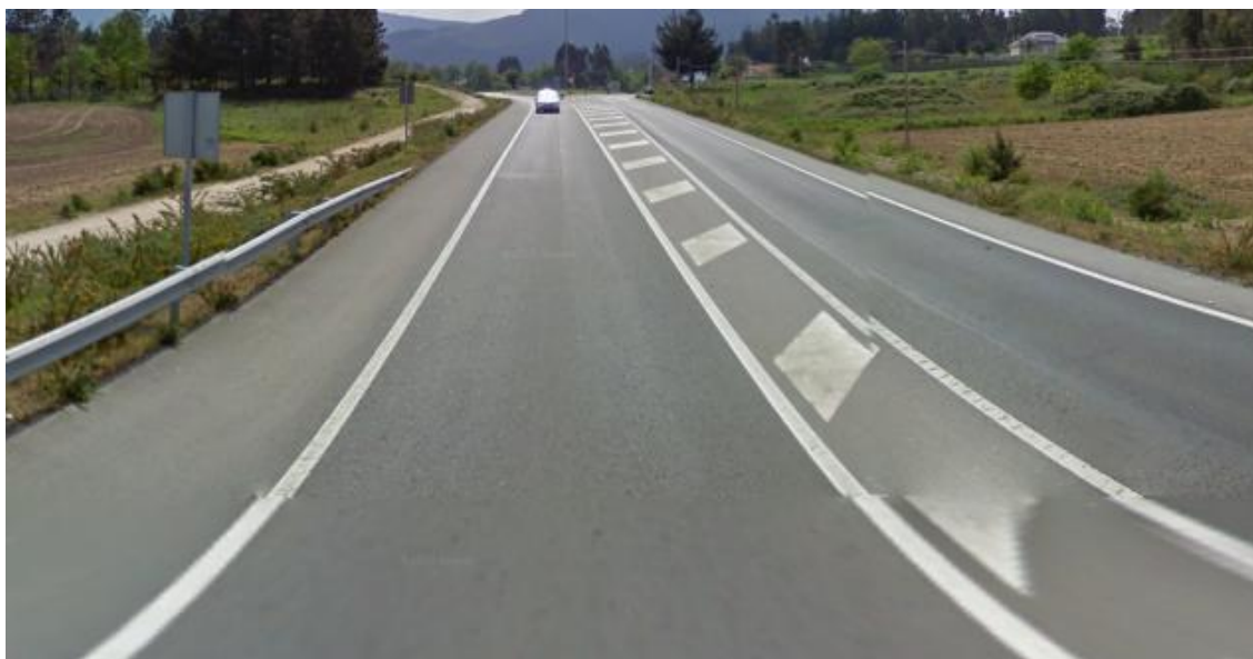
Foto 4: Final del tramo.
