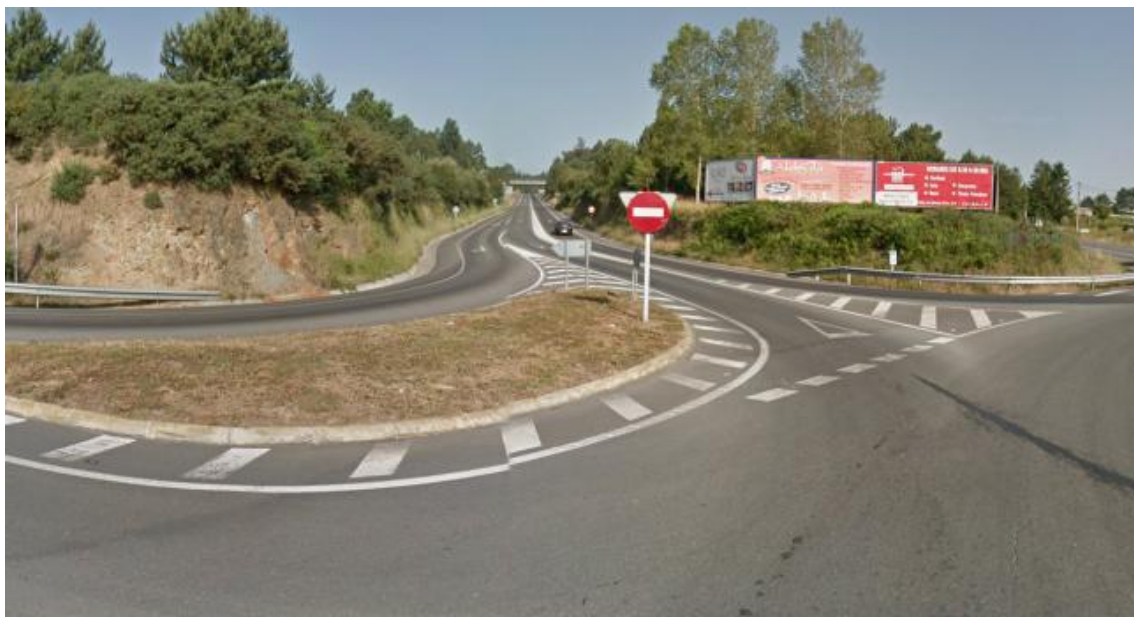
Foto 2: Inicio del tramo
