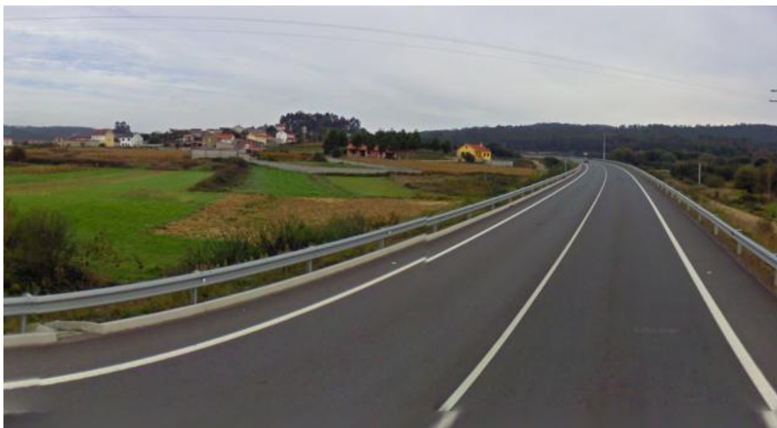
Foto 3: punto intermedio del tramo.
