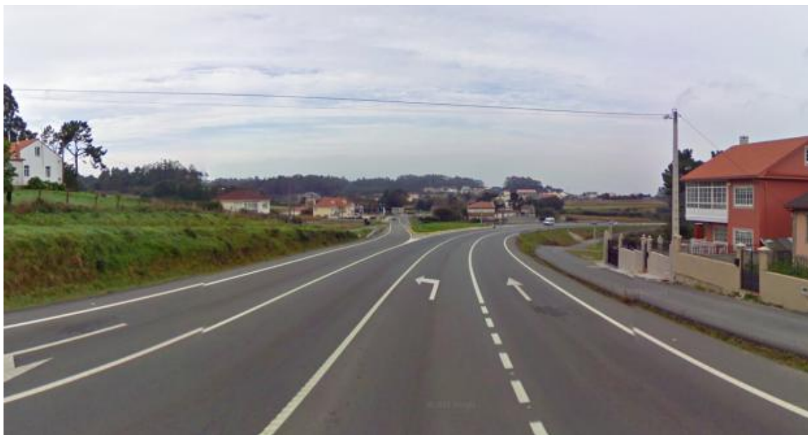
Foto 4: Final del tramo.
