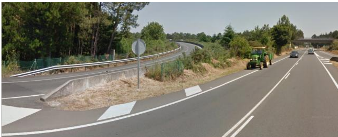
Foto 4: Final del tramo.
