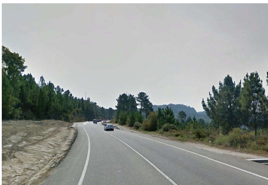
Tramo de carretera convencional antes de llegar al enlace con la A-52
