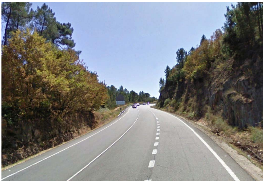
Tramo con carril lento entre el PK 4+820 y el PK 6+860
