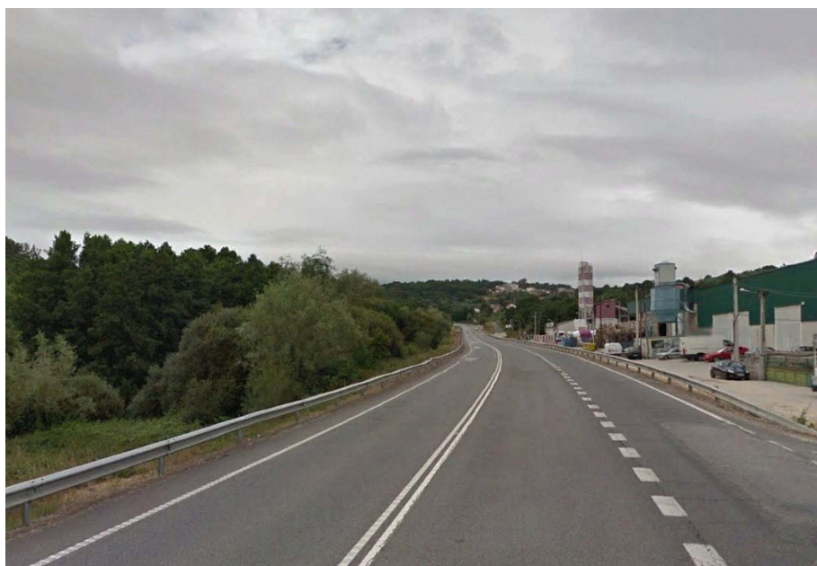
Tramo en pendiente con suelo industrial adyacente
