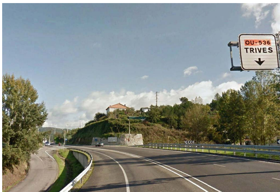
Puente en el PK 2+970
