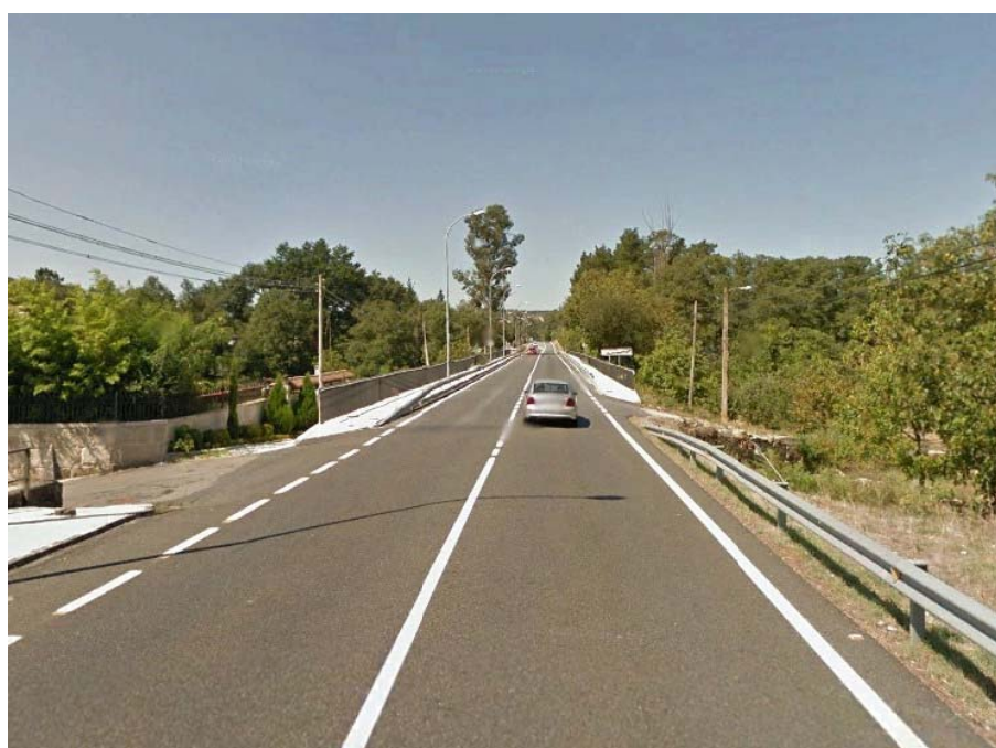
Puente sobre el río Loña en A Derrasa
