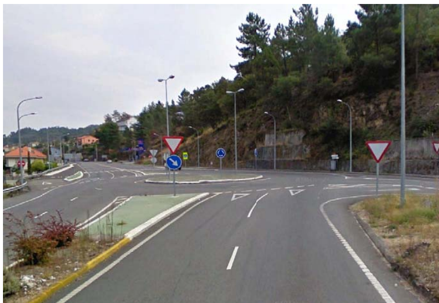
Rotonda en el PK 2+100. A partir de aquí la sección se reduce al pasar de cuatro carriles a tres, dos ascendentes y uno descendente
