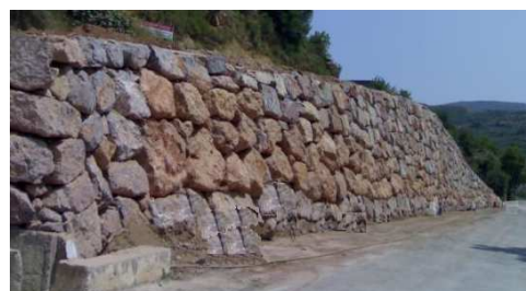
Muro de Escollera
