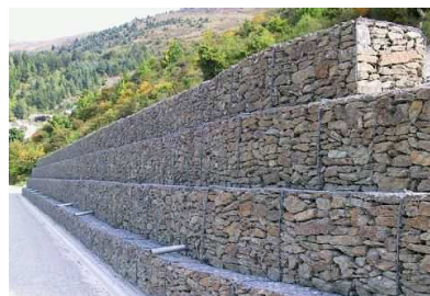
Muro de gaviones
