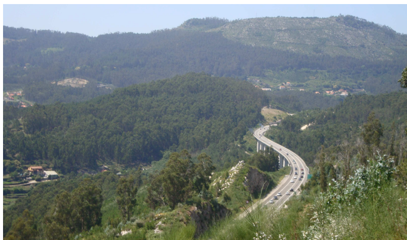
Zona futuro Viaducto A Mó
