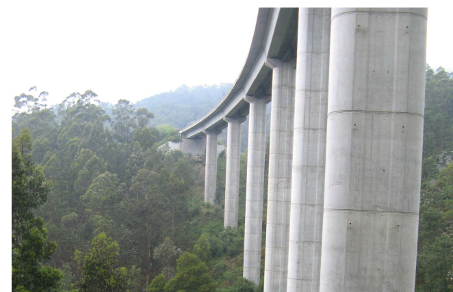
Vista actual Viaducto A Fraga
