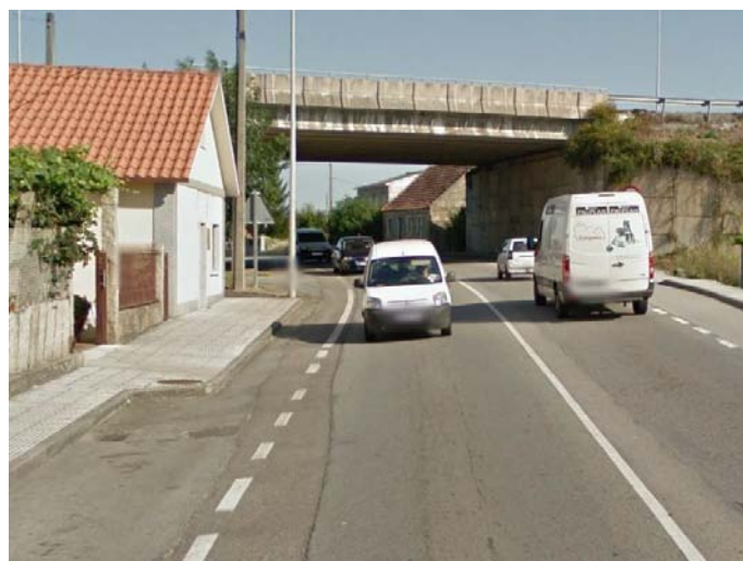
Figura 3. PO-504. zona final. Paso superior VG-4.1
