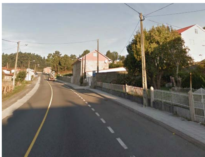
Figura 3. PO-308 a su paso por Encoirados
