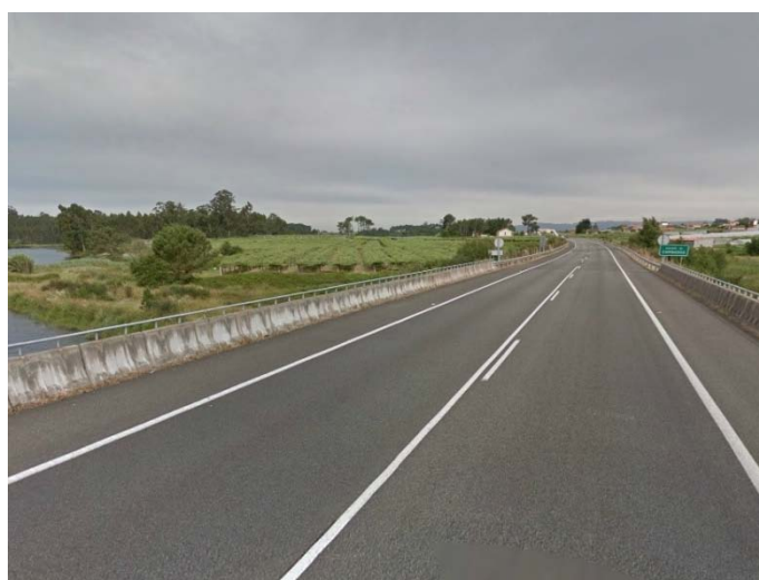
Figura 3. VG-4.2. Viaducto sobre el Río Umia.
