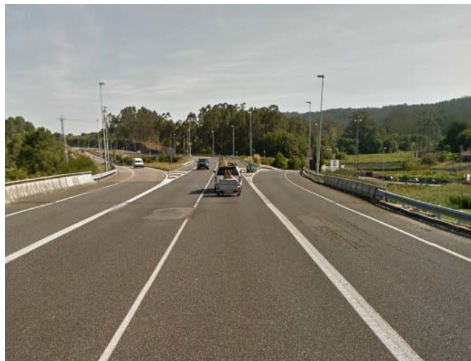
Figura 1. VG-4.1. Viaducto sobre O Vinquiño
