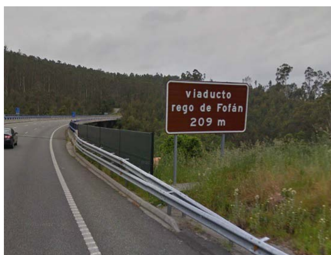
Figura 5. Viaducto Rego de Fofán. Pantallas acústicas
