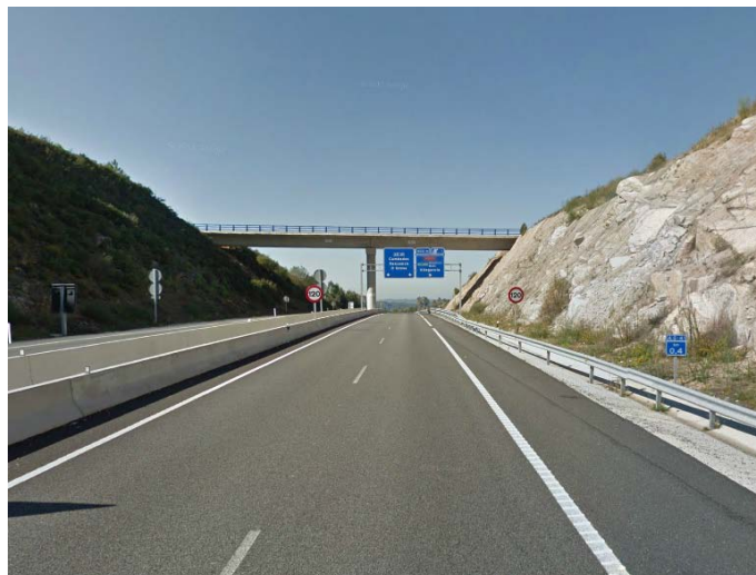
Figura 2. Inicio de la AG-42. Paso superior
