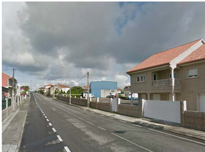
Figura 2. PO-550. Inicio del tramo hacia Cambados
