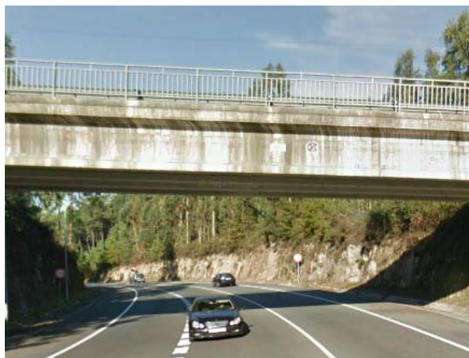
Figura 2. PO-529. Inicio del tramo. Paso superior
