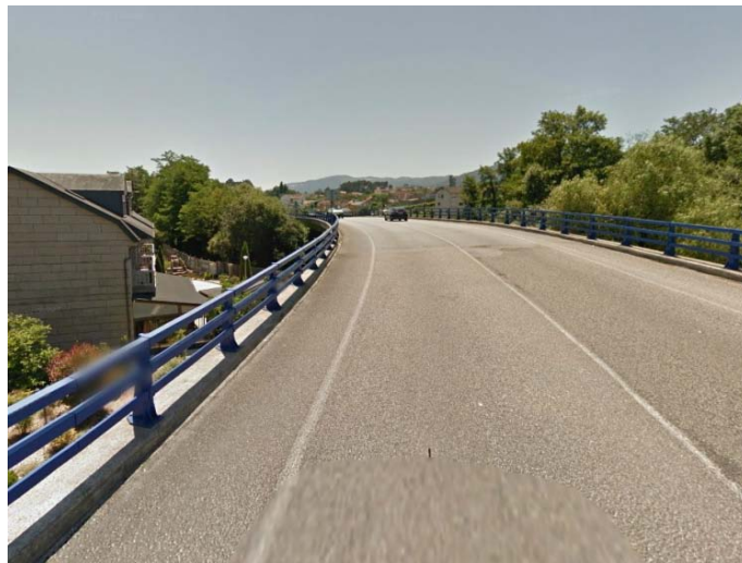
Figura 2. PO-511 viaducto río Louro
