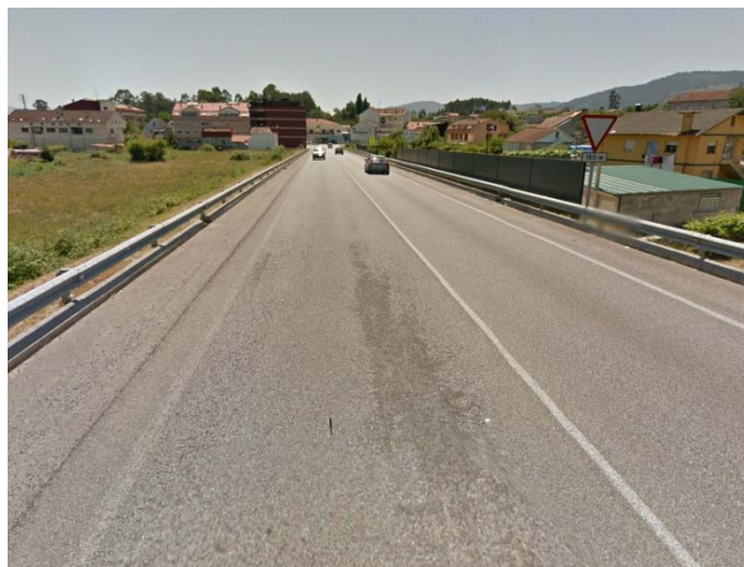
Figura 3. PO-511 fin del tramo
