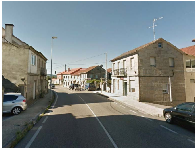
Figura 3. PO-331. Paso por A Torre
