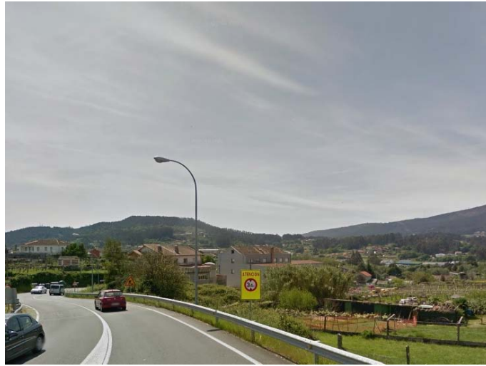
Figura 2. PO-225 inicio carretera
