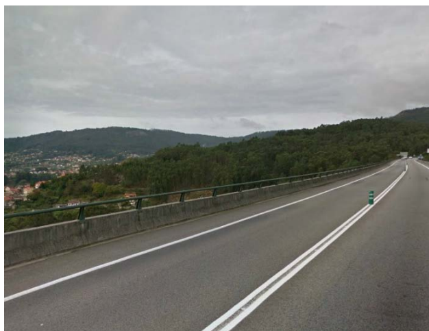
Figura 4. CG-4.1. Viaducto de Mo. Reibón
