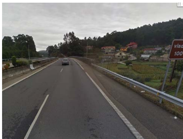
Figura 5. AG-57. Paso por A Fraga
