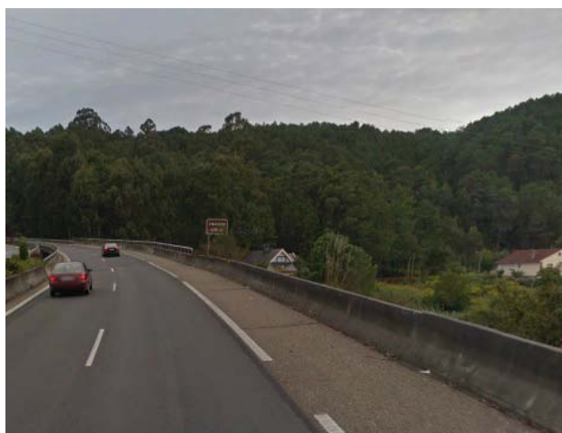
Figura 2. AG-57 Viaducto de Villaza. Gondomar
