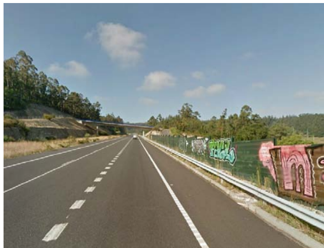
Figura 3. CG-1.5.Cerca del núcleo de Pazos. Pantallas acústicas
