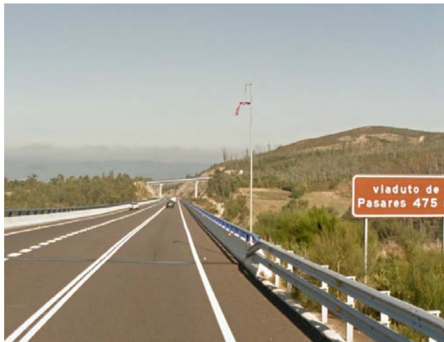
Figura 4. CG-1.5.Viaducto de Pasares
