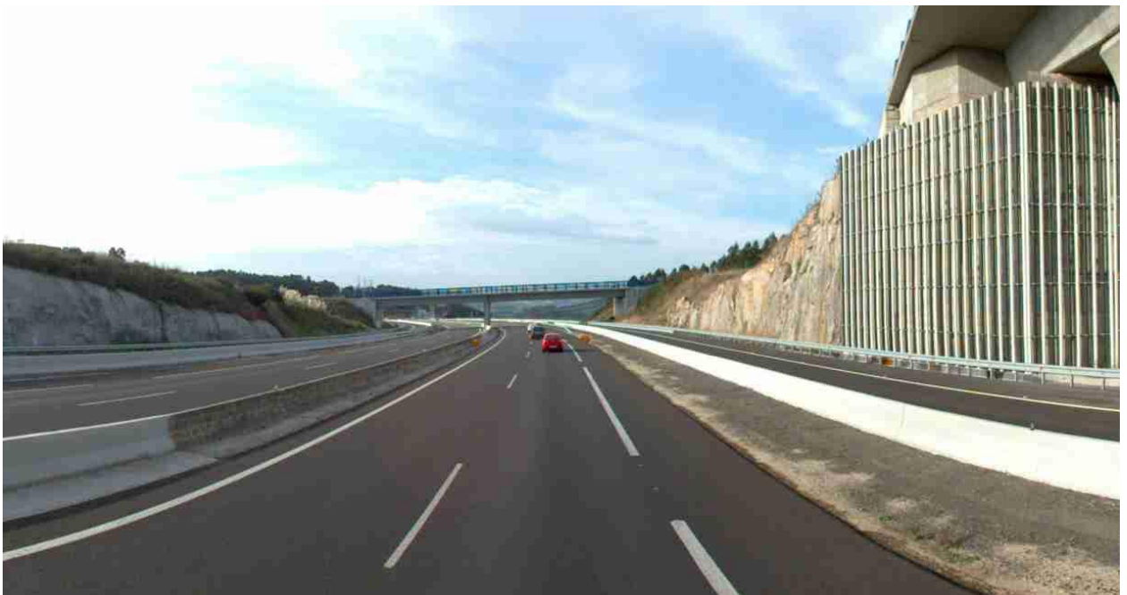
Autoestrada AG-55 A Coruña - Baio
