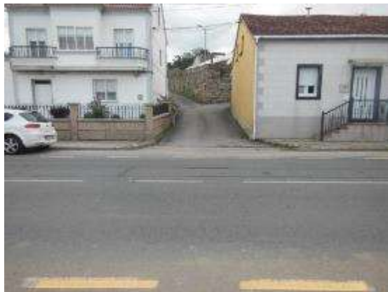
Foto 3. PK 4+040. Incorporación margen izquierdo sin señalización.
