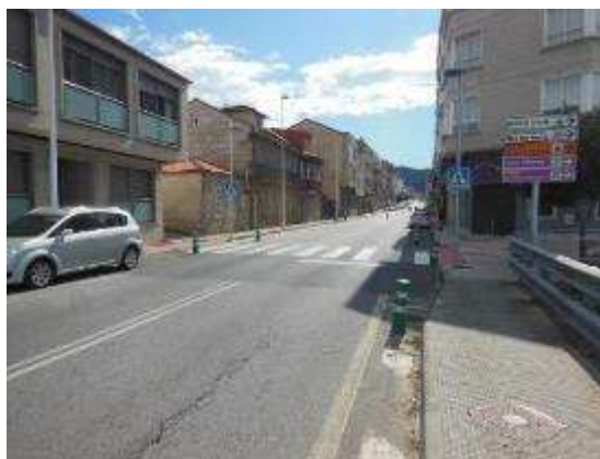
Foto 11. PK 10+770, sentido creciente. Paso de peatones con señalización LED y balizamiento.
