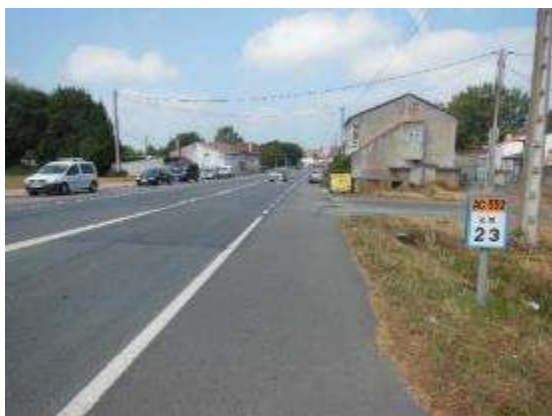
Foto 5. PK 23+000, sentido creciente. Entrada y salida aserradero y báscula sin señal de STOP.
