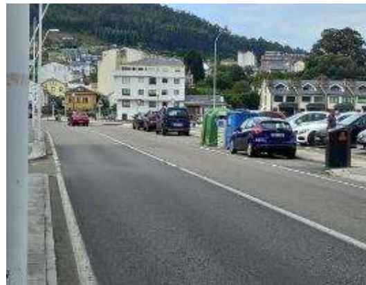
Foto 12. PK 83+650, sentido decreciente. Vista general. Reanálisis de encendido y apagado de las luminarias.
