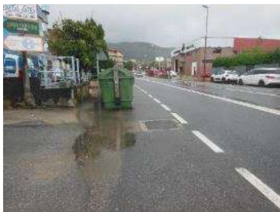
Foto 5. PK 2+290, incorporación margen izquierdo sin señalización.
