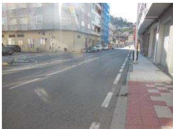
Foto 11. PK 0+730, sentido decreciente, vista general con giro permitido a la izquierda.
