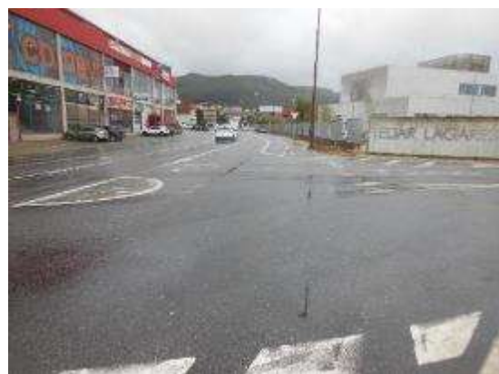
Foto 2. PK 2+200, sentido creciente, vista general.
