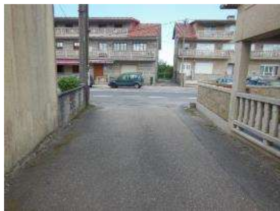
Foto 10. PK 8+640, incorporación margen izquierdo sin señalización.
