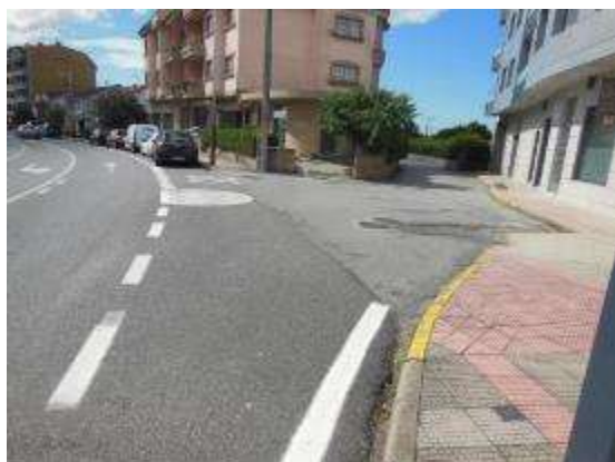
Foto 11. PK 8+730, cambio de sentido, sin señal vertical de STOP y señalización horizontal desgastada.
