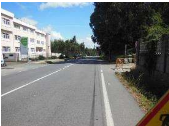
Foto 5. PK 3+150, sentido creciente. Incorporación margen derecho y salida residencia de mayores en margen izquierdo. Tacos en pintura para giros.
