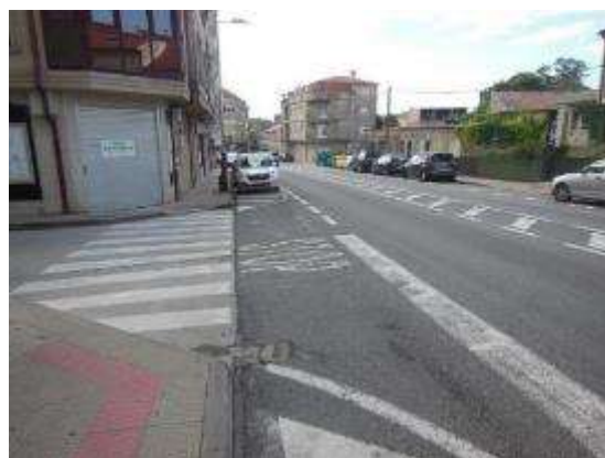
Foto 16. PK 9+080, incorporación margen izquierdo, señalización horizontal en mal estado.
