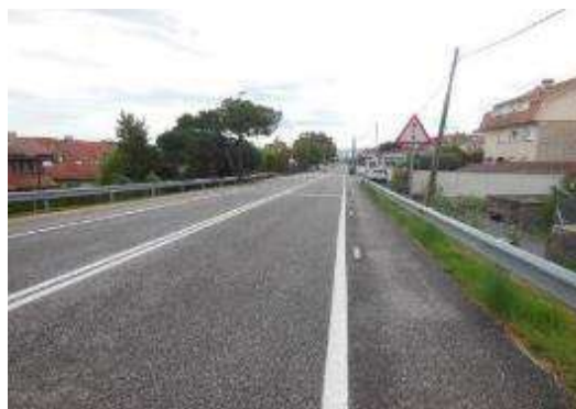
Foto 18. PK 3+370, sentido decreciente, señalización de tramo regulado por semáforos.
