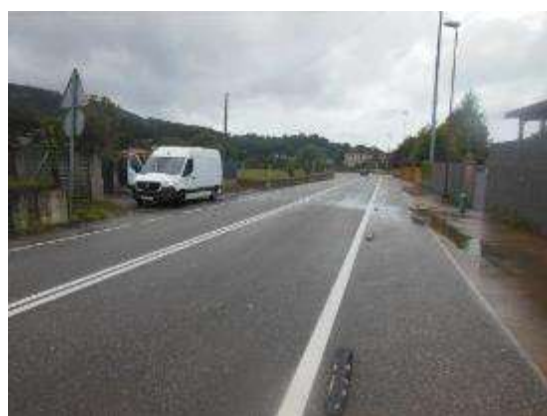
Foto 20. PK 3+220, sentido creciente, vista general.
