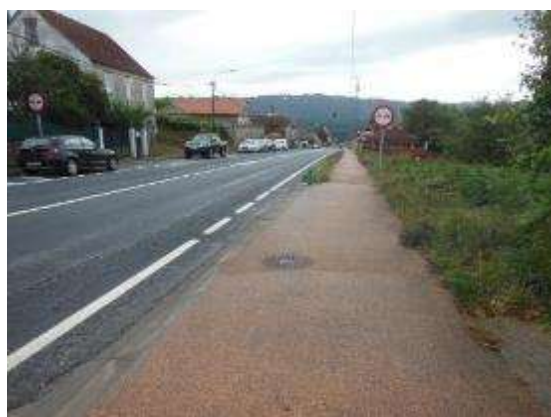
Foto 17. PK 2+040, sentido decreciente, vista general. Prohibición de adelantamiento y senda peatonal.
