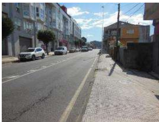
Foto 15. PK 11+000, sentido creciente, vista general.
