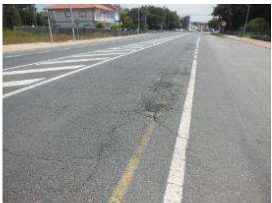
Foto 27. PK 24+020, sentido decreciente. Zona blandón en margen izquierdo, parada de bus.
