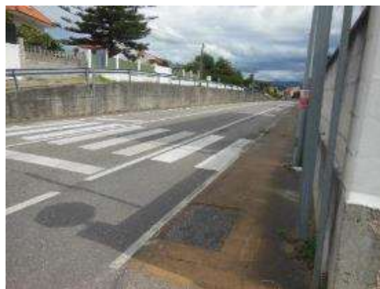
Foto 6. PK 11+630, sentido creciente, vista general.
