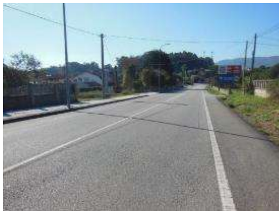
Foto 1. PK 10+600, sentido creciente, inicio del tramo vista general.
