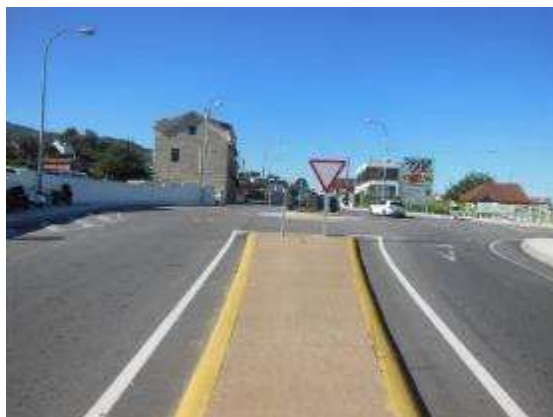
Foto 11. PK 1+750, sentido creciente, vista general glorieta.
