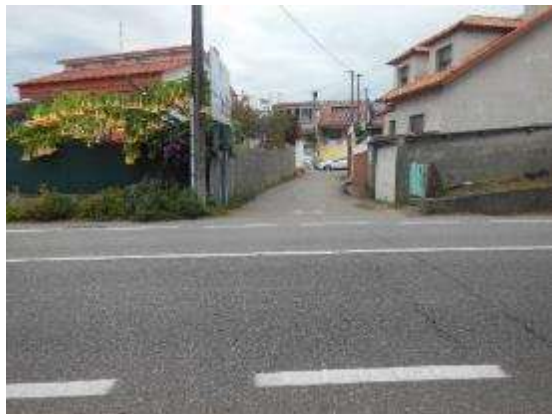
Foto 3. PK 11+610, incorporación margen izquierdo sin señalizar horizontalmente.
