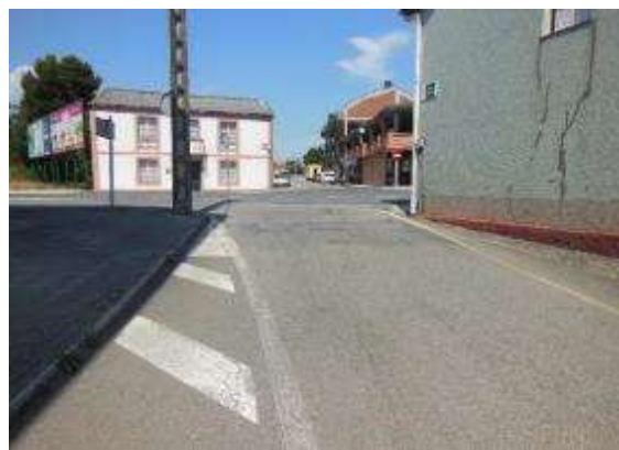
Foto 18. PK 30+220. Calle unidireccional sin salida a AC-552 sin señalización.
