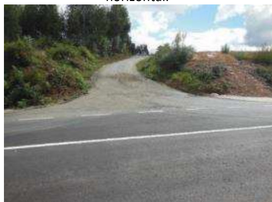
Foto 6. PK 3+130. Incorporación margen izquierdo sin ninguna señalización. Línea continua en el tramo.
