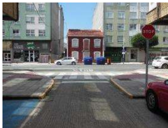
Foto 12. PK 3+960, incorporación margen derecha con señalización vertical y horizontal, discontinuidad en el pavimento.
