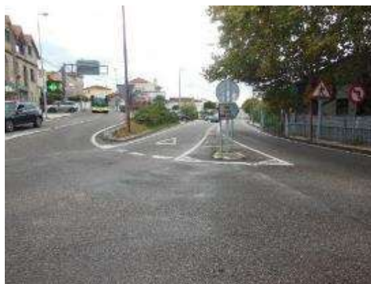
Foto 10. PK 5+120, sentido creciente, glorieta.
