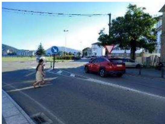
Foto 5. PK 85+000, sentido creciente. Vista general, peatones invadiendo la calzada de forma antirreglamentaria.
