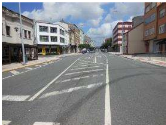
Foto 9. PK 3+700, sentido creciente. Vista general, marcas de frenada cruzando el cebreado y el carril.
