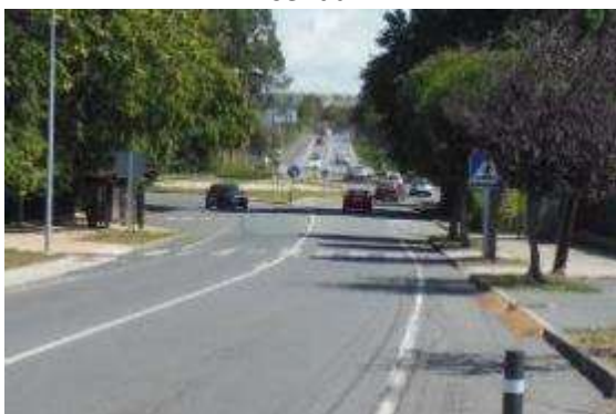
Foto 14. PK 3+550, sentido creciente. Vista general, señal paso de peatones y límite de velocidad. Convendría repintar el paso de peatones y elevar bordillo en el margen derecho e igualarlo a los anteriores.
