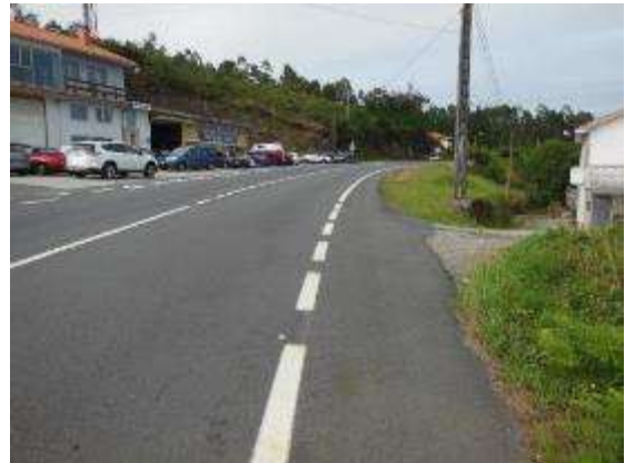
Foto 10. PK 74+920, sentido creciente, incorporación sin señalización.
