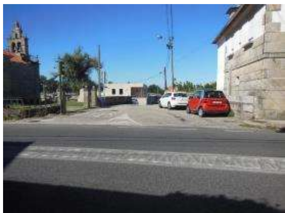
Foto 23. PK 2+920, incorporación margen derecho semaforizada y con señalización horizontal, sin señal de STOP. Marcas viales en mal estado.
