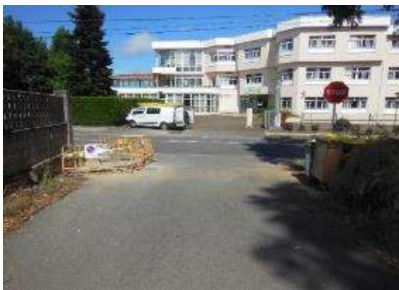
Foto 6. PK 3+140. Incorporación margen derecho con señal de STOP, sólo se permite salida en sentido creciente. Falta señal dirección obligatoria.
