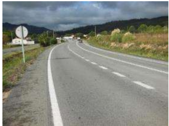
Foto 6. PK 0+630, sentido creciente. Vista general.
