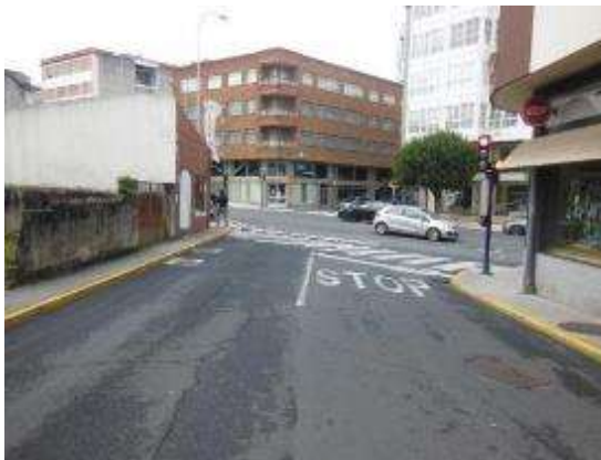
Foto 19. PK 2+980, incorporación margen izquierdo semaforizada y con señalización vertical y horizontal de STOP.
