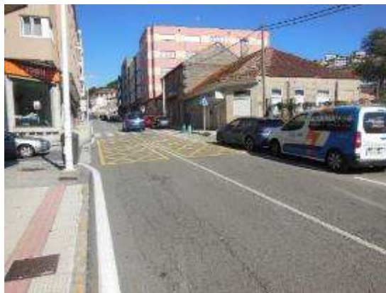
Foto 5. PK 0+130, sentido decreciente, incorporación margen derecho con poca visibilidad.
