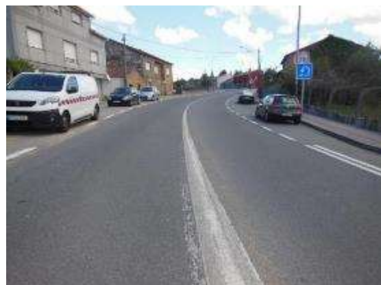
Foto 2. PK 8+400, sentido decreciente, vista general.
