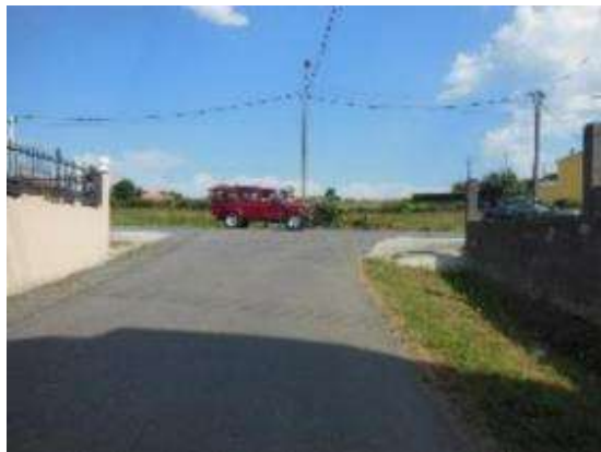
Foto 3. Incorporación margen izquierdo, PK 28+710 sin señal de STOP
