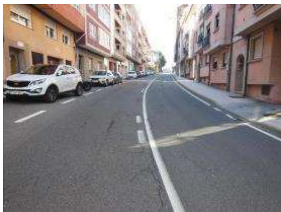
Foto 15. PK 0+900, sentido creciente, vista general.
