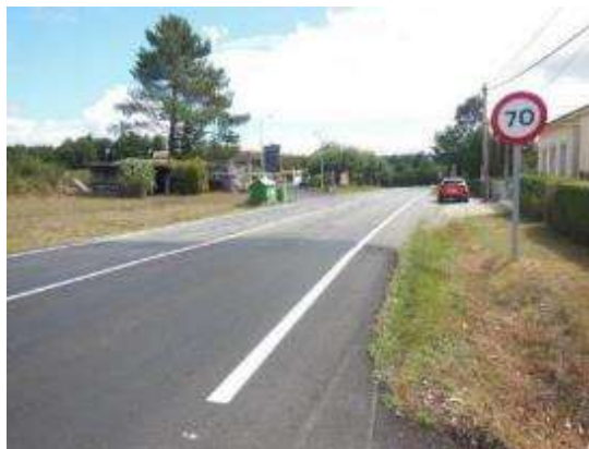
Foto 7. PK 3+350, sentido creciente. Vista general, velocidad limitada a 70 km/h con línea continua.
