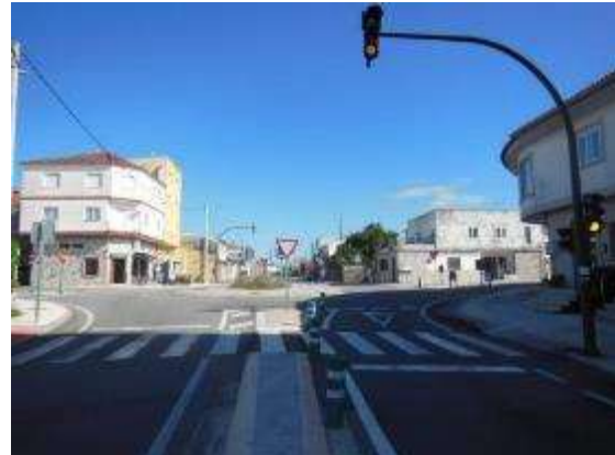
Foto 12. PK 9+070, sentido decreciente, vista de la glorieta.
