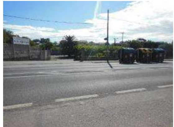
Foto 16. PK 9+200, acceso a propiedades margen izquierdo sin señalización.
