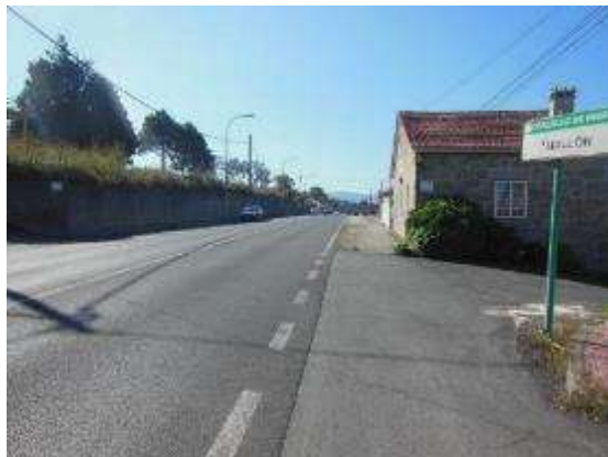
Foto 9. PK 11+290, incorporación margen derecho sin señalización, cambio de rasante.
