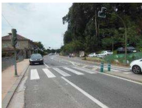
Foto 7. PK 18+140, paso de peatones semaforizado. Con zona de refugio central, balizamiento en buen estado.
