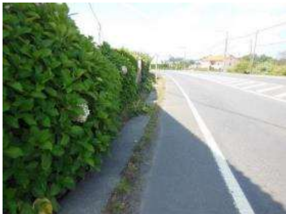
Foto 17. PK 23+420, sentido creciente, zona arcén +/- 1.00 m en margen izquierdo.
