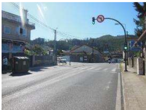
Foto 21. PK 2+880, sentido creciente. Intersección semaforizada, marcas viales y paso de peatones desgastados.
