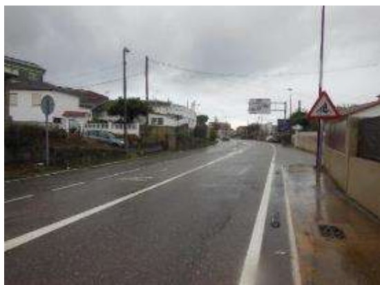
Foto 15. PK 2+850, sentido creciente. Señalización de itinerario ciclista, vista general.
