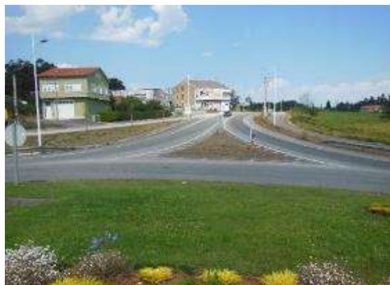
Foto 12. PK 29+390. Vista general de entrada y salida a la rotonda. Acceso al polígono y autopista.
