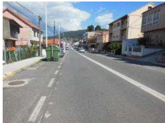
Foto 2. PK 10+100, sentido decreciente, vista general.
