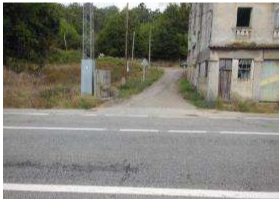
Foto 15. PK 18+380, incorporación margen derecho sin señalización.
