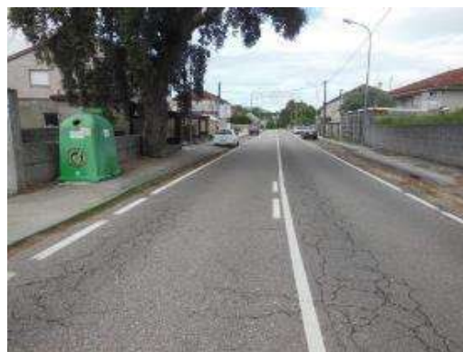
Foto 22. PK 1+610, sentido decreciente, vista general, final del tramo.
