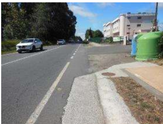
Foto 8. PK 3+250, sentido decreciente. Vista general, entrada residencia. Termina la acera y después continúa la senda.
