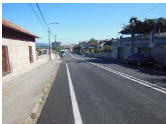
Foto 19. PK 2+630, vista hacia sentido decreciente.
