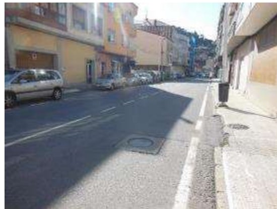
Foto 10. PK 0+670, sentido creciente, vista general y accesos a propiedades.
