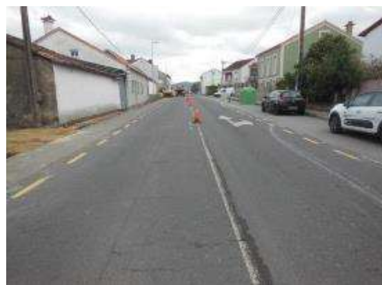
Foto 2. PK 4+000, sentido decreciente, vista general.
