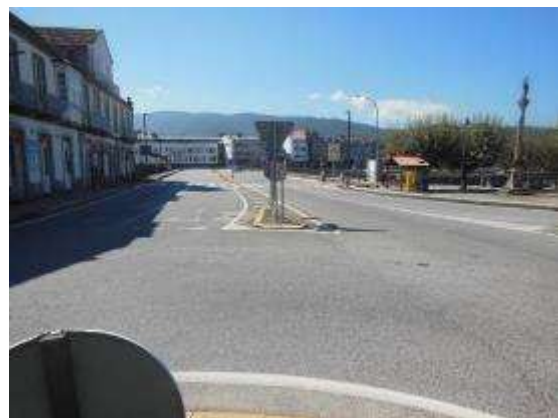
Foto 18. PK 12+820, sentido creciente. Ramal glorieta, marcas viales desgastadas y señalización horizontal de ceda en mal estado. Paso de peatones al salir de la curva.
