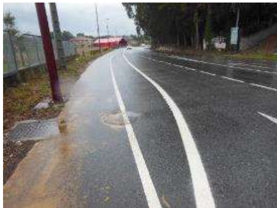
Foto 3. PK 2+200, sentido decreciente, vista general.
