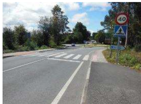
Foto 20. PK 3+700, sentido decreciente. Vista general final del tramo. Paso de peatones.
