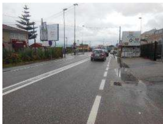
Foto 18. PK 3+020, sentido decreciente, vista general.
