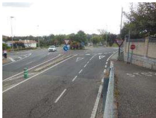
Foto 16. PK 12+470, sentido decreciente. Incorporación a carril de acceso a glorieta, con señalización vertical y horizontal, cambio de rasante y visibilidad limitada.
