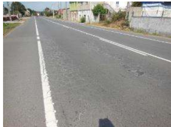
Foto 2. PK 28+660, sentido creciente, blandón carril izquierdo. Salidas de vivienda en margen izquierdo y derecho.
