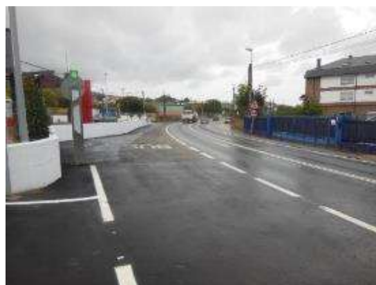
Foto 8. PK 2+430, sentido creciente, vista general.
