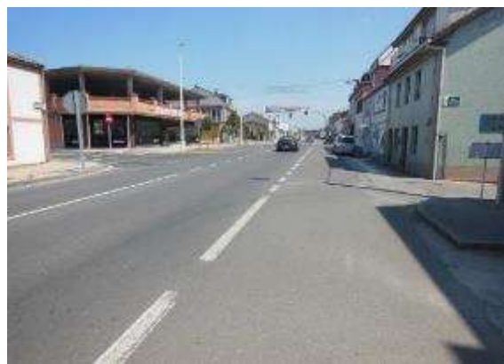
Foto 20. PK 30+220, sentido decreciente. Vista general incorporaciones margen izquierdo y margen derecho. Final del tramo.
