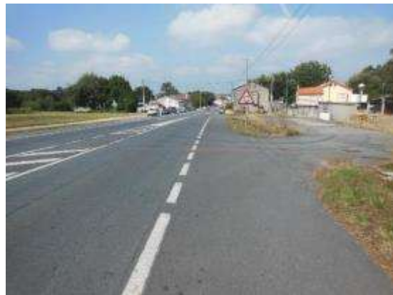
Foto 4. PK 22+970, sentido creciente. Entrada báscula y señalización glorieta.
