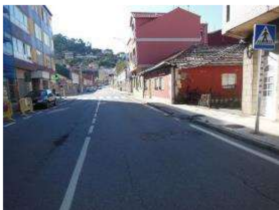
Foto 13. PK 0+760, sentido creciente vista general.
