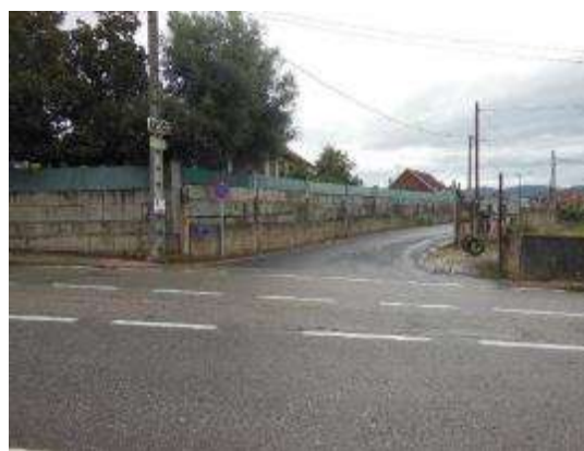
Foto 14. PK 1+820, incorporación margen derecho, sin señalización.
