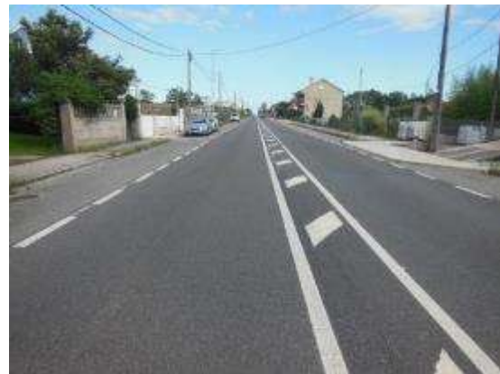
Foto 2. PK 8+440, sentido decreciente, vista general.
