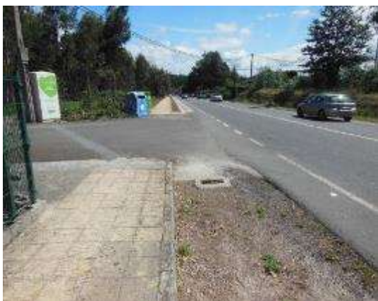
Foto 7. PK 3+220, sentido creciente. Vista general, entrada residencia. Termina la acera y después continúa la senda.
