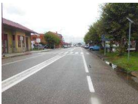
Foto 19. PK 3+140, sentido decreciente. Señal de paso de peatones cubierta por la vegetación.
