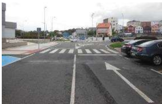
Foto 7. PK 3+120, ramal glorieta Rúa Garda.
