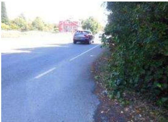
Foto 10. PK 3+390, sentido creciente. Incorporación margen derecho. Mala visibilidad, hay mucha vegetación.
