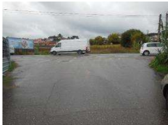
Foto 12. PK 2+550, incorporación margen derecho sin señalización.
