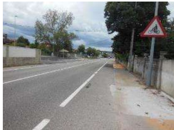
Foto 10. PK 12+290, sentido creciente, vista general.
