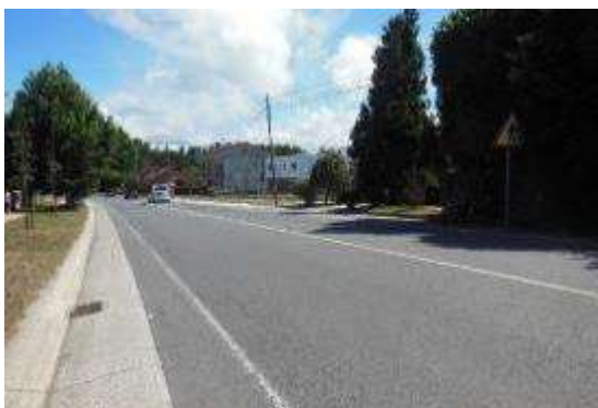
Foto 13. PK 3+430, sentido creciente. Vista general. Buena visibilidad, pero señal de peligro paso de peatones oculta por la vegetación.
