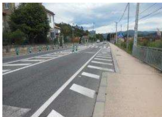
Foto 20. PK 17+750, sentido decreciente, vista del paso de peatones.
