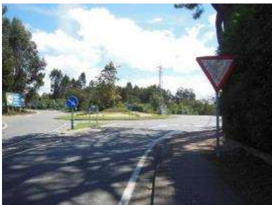
Foto 17. PK 3+650, entrada a glorieta. AC-190 Santa Cruz. Señal de ceda muy deteriorada.
