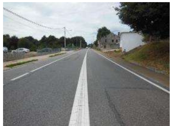
Foto 14. PK 18+300, sentido creciente, vista general.
