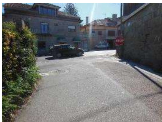
Foto 20. PK 2+850, incorporación margen derecho. Señal de STOP antigua y a baja altura, sin señalización horizontal.
