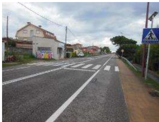
Foto 16. PK 5+270, sentido creciente. Paso de peatones con señal LED.
