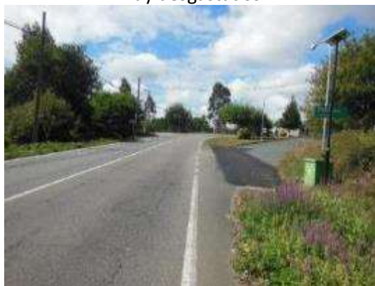
Foto 11. PK 3+550, sentido decreciente. Vista general, acceso a la gasolinera.
