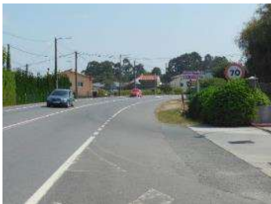
Foto 21. PK 23+610, sentido decreciente, señalización de limitación de velocidad camuflada.
