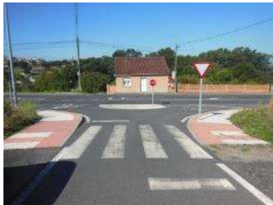
Foto 10. PK 11+500, intersección margen izquierdo, señalización horizontal desgastada.
