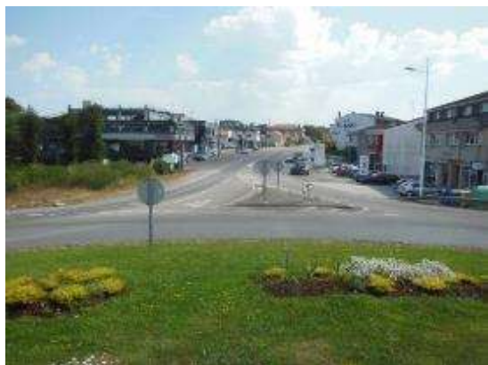
Foto 11. PK 29+390, sentido decreciente. Incorporación a la AC-552 desde rotonda.
