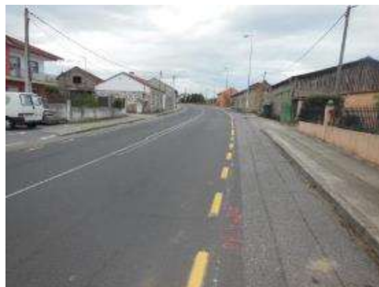
Foto 6. PK 4+200, sentido creciente, vista general. Accesos a viviendas en ambos márgenes.
