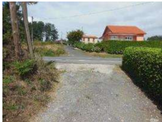
Foto 4. PK 2+950. Incorporación margen derecho, sin señalización vertical ni horizontal.
