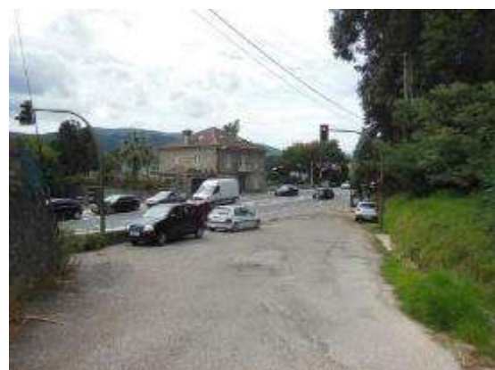
Foto 8. PK 18+150, incorporación semaforizada margen derecho. Cambio de rasante y pavimento discontinuo.
