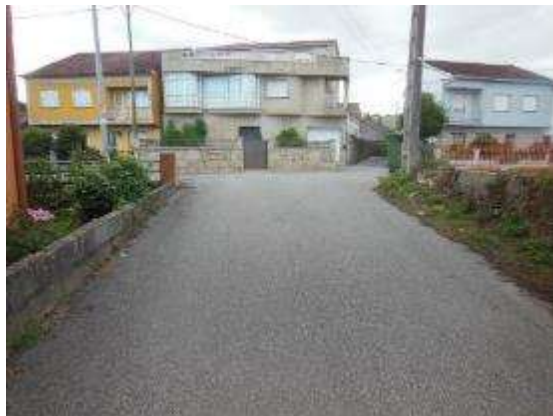
Foto 9. PK 4+340, incorporación margen derecho sin señalización. Cambio de rasante.
