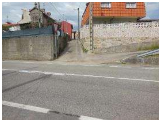
Foto 5. PK 11+630, acceso a viviendas margen izquierdo sin señalización horizontal y cambio de rasante.
