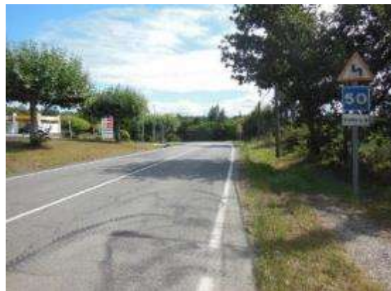
Foto 8. PK 3+420, sentido creciente. Vista general, señalización en mal estado de tramo de curvas y velocidad recomendada. Arcén margen derecho inexistente.
