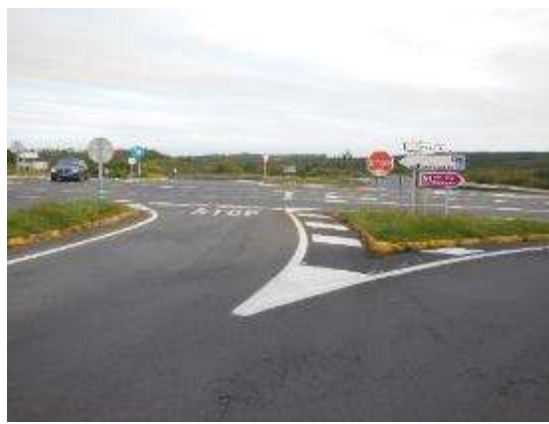
Foto 6. PK 74+770, Incorporación a la AC-552 desde la AC-441.
