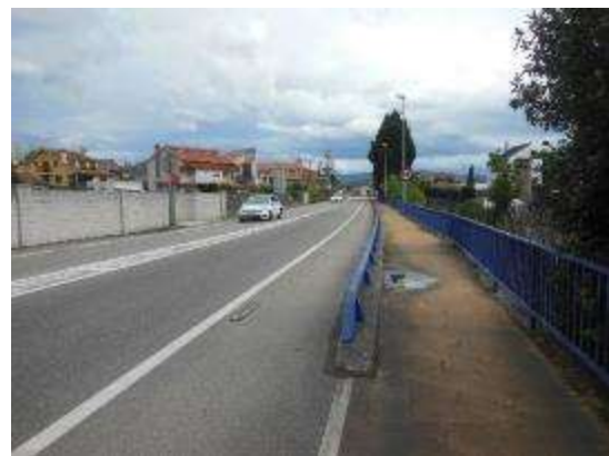
Foto 2. PK 11+520, sentido creciente. Vista general.
