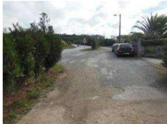
Foto 10. PK 0+700. Incorporación margen izquierdo cambio en el tipo de pavimento, vista hacia sentido decreciente.
