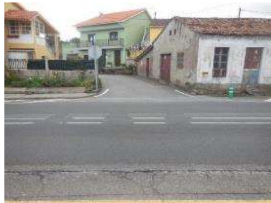
Foto 10. PK 4+450, incorporación margen izquierdo. Señal vertical de STOP pero sin señalización horizontal. Marcas viales antiguas que se solapan con las más recientes.
