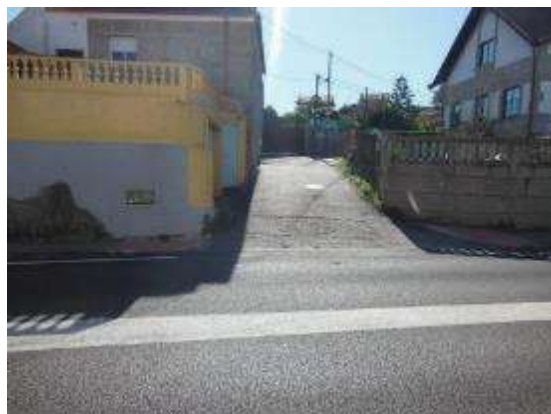
Foto 18. PK 2+480, incorporación margen izquierdo sin ninguna señalización y con cambio de rasante.
