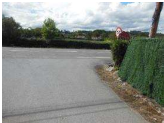
Foto 19. PK 3+850. Incorporación margen izquierdo. Señalización vertical de STOP en mal estado y oculta por la vegetación. No existe señalización horizontal.
