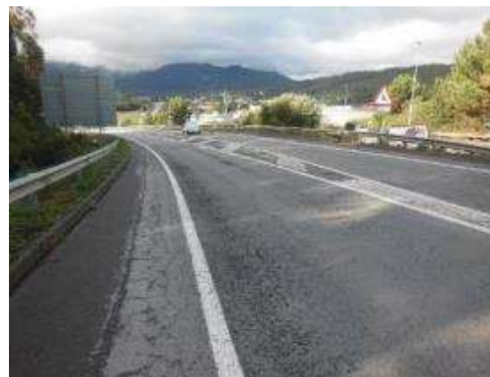
Foto 2. PK 0+100, sentido creciente. Vista general.
