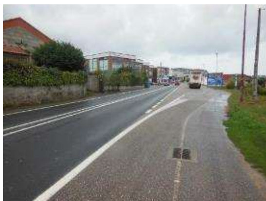
Foto 13. PK 2+590, sentido creciente, vista general.
