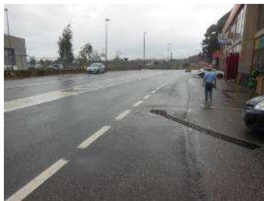
Foto 6. PK 2+290, sentido decreciente vista general.
