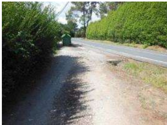
Foto 3. PK 2+860. Acceso a viviendas margen derecho, sin señalización vertical ni horizontal.
