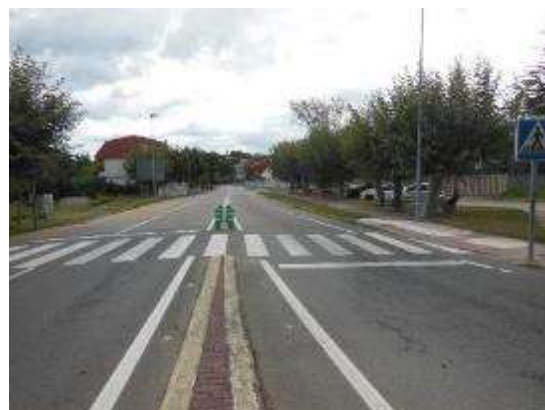
Foto 14. PK 12+430, sentido decreciente. Vista general, paso de peatones.
