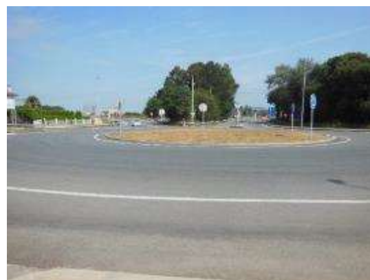
Foto 8. PK 23+200, glorieta con mayor punto de concentración de accidentes.
