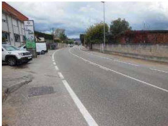
Foto 9. PK 12+210, sentido decreciente, vista general.
