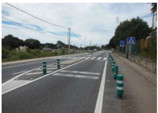
Foto 19. PK 18+710, sentido creciente. Paso de peatones con refugio central, delante del centro escolar. Balizamiento en buen estado. Señalización de cambio de sentido en unos metros.
