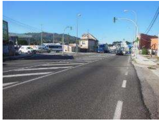
Foto 4. PK 1+050, sentido creciente, intersección regulada por semáforo. Acceso a superficies comerciales margen derecho sin señalizar y con discontinuidad en el pavimento por diferencia de cota.
