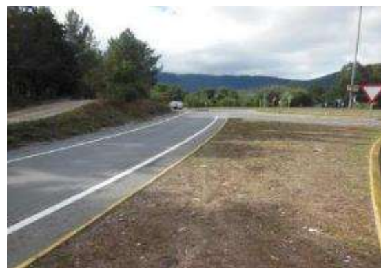
Foto 28. PK 1+770, sentido creciente, isleta central.
