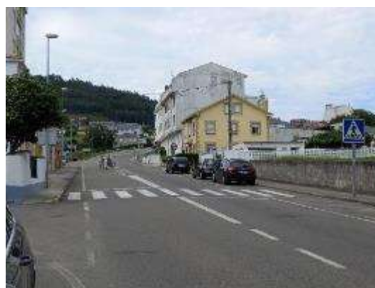
Foto 8. PK 83+400, sentido decreciente. Vista general, peatones cruzando.
