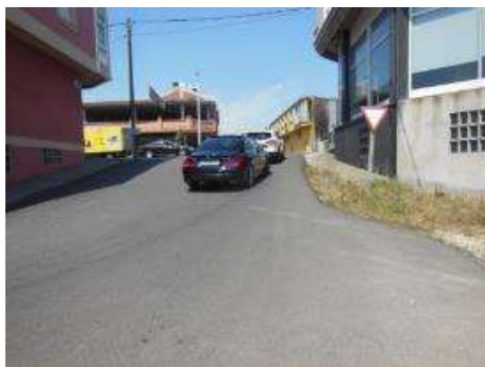
Foto 17. PK 30+170. Vista general incorporación margen izquierdo. Señal de ceda.
