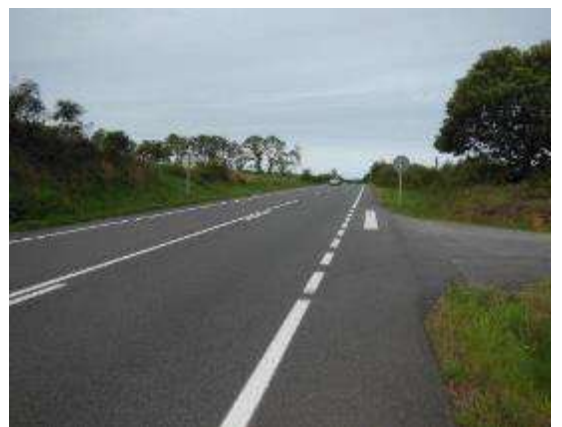
Foto 14. PK 75+320, decreciente, vista final del tramo, incorporación desde margen derecho.
