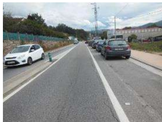
Foto 6. PK 18+110, sentido decreciente. Vista general, vehículos estacionados en arcén.
