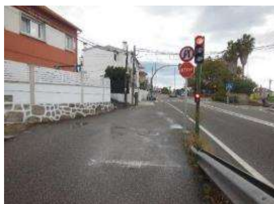
Foto 8. PK 5+040, incorporación margen izquierdo, regulada por semáforo, con señal de STOP y prohibición de cambio de sentido. Sin señalización horizontal.
