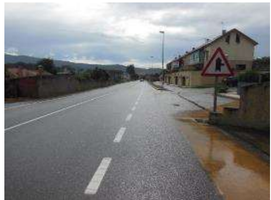
Foto 24. PK 13+130, sentido creciente. Señalización de intersección con prioridad.
