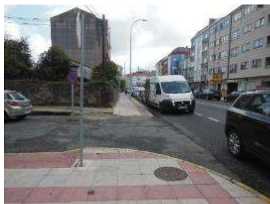
Foto 5. PK 2+470, margen izquierdo. No existe paso de peatones ni señal de STOP. Discontinuidad en el pavimento por diferencia de cota.
