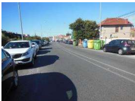
Foto 13. PK 1+880, sentido creciente. Vista general, marcas viales desgastadas.
