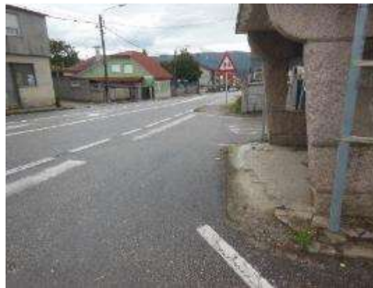
Foto 16. PK 1+890, sentido decreciente. Señalización de advertencia de zona escolar.
