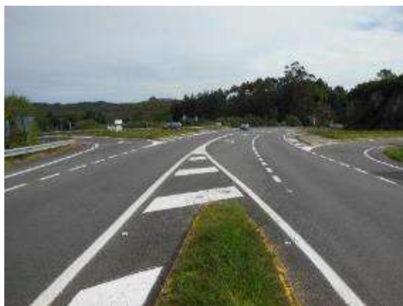
Foto 7. 74+830, sentido decreciente, vista general de la intersección desde la isleta.
