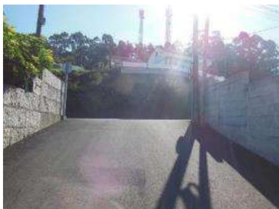
Foto 7. PK 11+100, sentido creciente, incorporación margen derecho sin señalización. Cambio de rasante.
