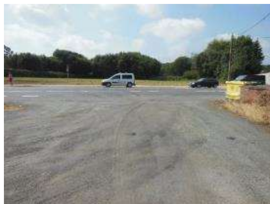
Foto 6. PK 23+020, incorporación margen derecho sin señal de STOP.
