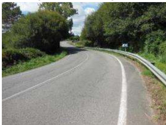
Foto 13. PK 3+660, sentido decreciente. Vista general, sucesión de curvas a izquierda y derecha. Existe un solo panel direccional.
