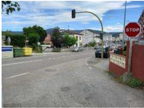
Foto 9. PK 83+500. Incorporación margen derecho con señal STOP mal colocada.
