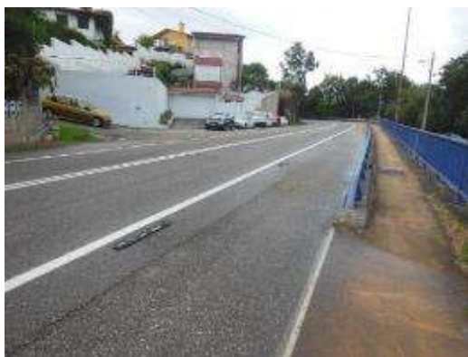
Foto 1. PK 4+500, sentido creciente, vista general.
