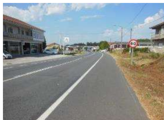
Foto 8. PK 28+950, sentido creciente. Curva a la izquierda, inicio zona adelantamiento en sentido decreciente.
