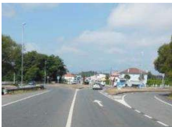
Foto 7. PK 23+140, sentido creciente, vista general acceso autopista. Isletas de la glorieta pequeñas.
