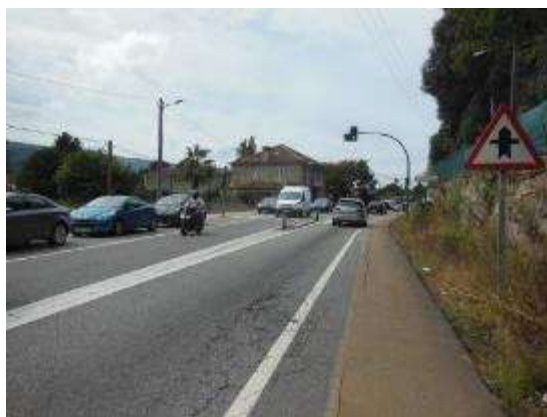
Foto 5. PK 18+110, sentido creciente. Intersección semaforizada. Señalización de intersección con prioridad.
