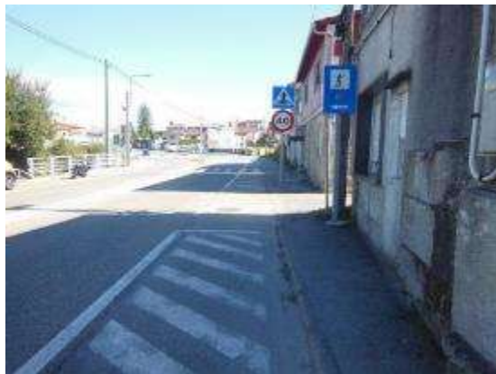
Foto 27. PK 3+140, sentido decreciente. Señalización de Camino de Santiago y paso de peatones a continuación. Marcas viales desgastadas.
