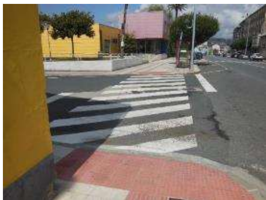
Foto 13. PK 4+160, incorporación margen izquierdo. Visibilidad reducida por la edificación existe de los peatones que cruzan por el paso. Parada de bus antes de la intersección.
