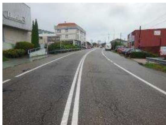
Foto 14. PK 2+750, sentido creciente, vista general.
