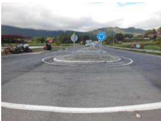
Foto 22. PK 1+350, sentido creciente, glorieta de diámetro 7 metros.
