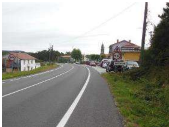
Foto 13. PK 75+000, sentido decreciente, señalización límite velocidad y cruce peligroso.
