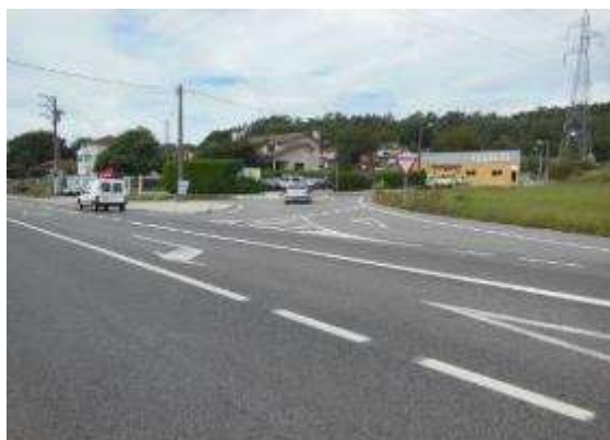
Foto 21. PK 18+830, vista de la intersección con cambio de sentido.
