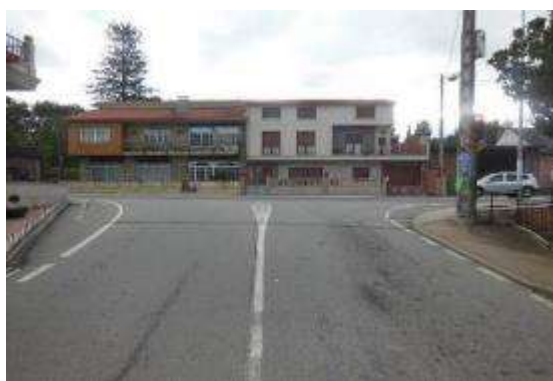
Foto 13. PK 4+630, incorporación margen derecho semaforizada. Señal de STOP oculta parcialmente por semáforo. Cambio de rasante y marcas viales desgastadas.
