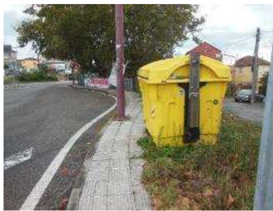
Foto 12. PK 5+100, acera estrecha con mobiliario urbano ocupando parte de ella.
