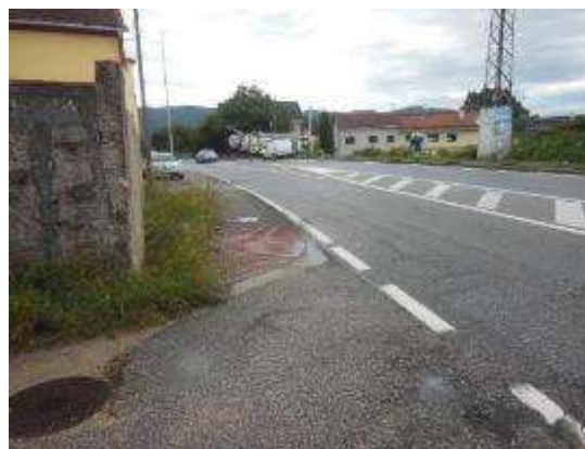
Foto 6. PK 1+490, incorporación margen derecho, vista hacia sentido decreciente.
