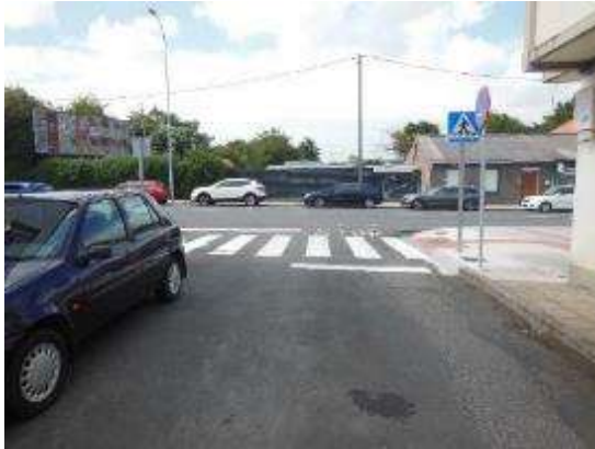
Foto 15. PK 4+520, incorporación margen derecho sin señal vertical de STOP y señal horizontal desgastada.
