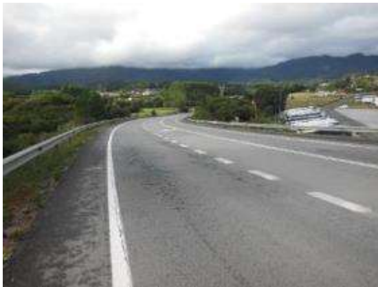
Foto 5. PK 0+350, sentido creciente. Vista general.
