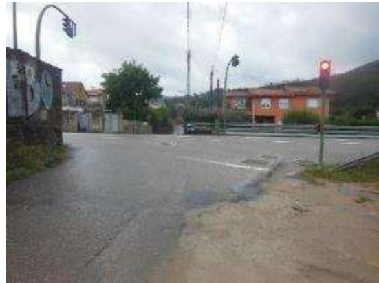
Foto 22. PK 3+450, intersección margen derecho regulada por semáforos. Pavimento irregular de diferentes tipos. Marcas viales muy desgastadas.
