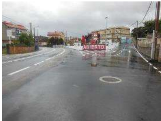
Foto 10. PK 2+510, sentido decreciente, vista general. Parada de autobús e incorporaciones.
