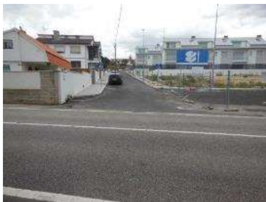
Foto 11. PK 12+320, incorporación margen izquierdo sin señalización.
