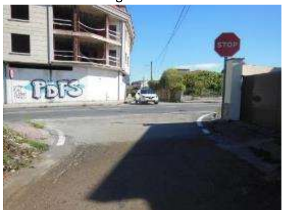
Foto 17. PK 9+560, incorporación en ambos márgenes con señales de STOP. No existe señalización horizontal.
