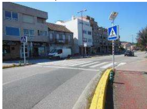
Foto 20. PK 12+950, sentido creciente, paso de peatones con señalización led en medio de la curva, cuatro carriles de circulación. Refugio para peatones en la mitad del paso.
