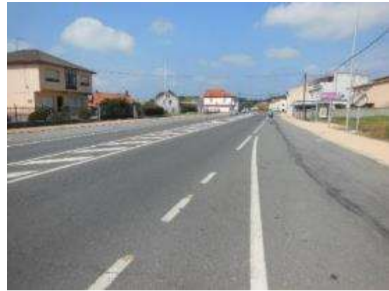
Foto 10. PK 23+320, sentido creciente, vista general parada bus margen derecho.
