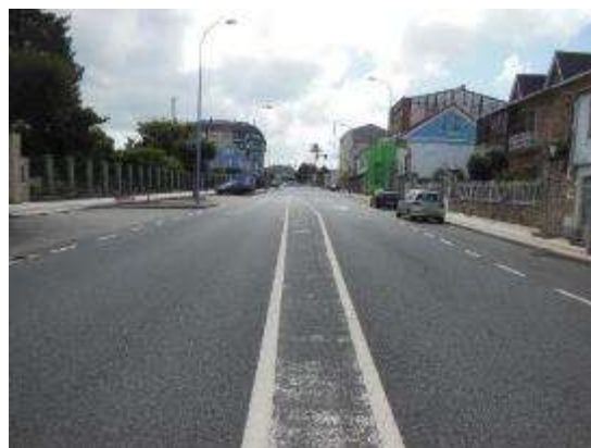
Foto 14. PK 4+440, sentido decreciente. Vista general, cebreado de separación de carriles en mal estado.
