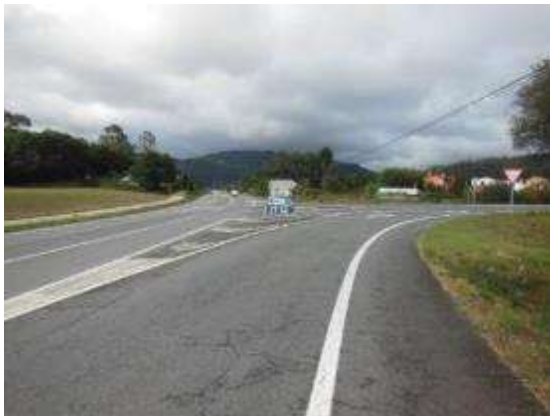
Foto 11. PK 0+850, sentido creciente. Vista general, carril de deceleración.
