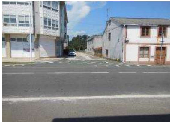
Foto 16. PK 29+850. Vista general incorporación margen derecho.
