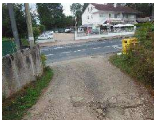
Foto 18. PK 2+040, incorporación margen derecho. Cambio de rasante y pavimento diferente. No existe señalización, visibilidad reducida por muro existente.
