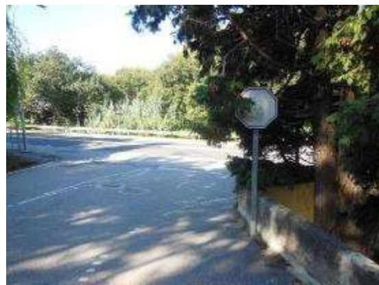
Foto 6. PK 10+960, incorporación margen izquierdo. Señal de STOP antigua y en muy mal estado, medio oculta por la vegetación. Señalización horizontal desgastada. Sin señal de dirección obligatoria a la derecha.
