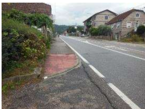
Foto 13. PK 1+720, incorporación margen izquierdo
