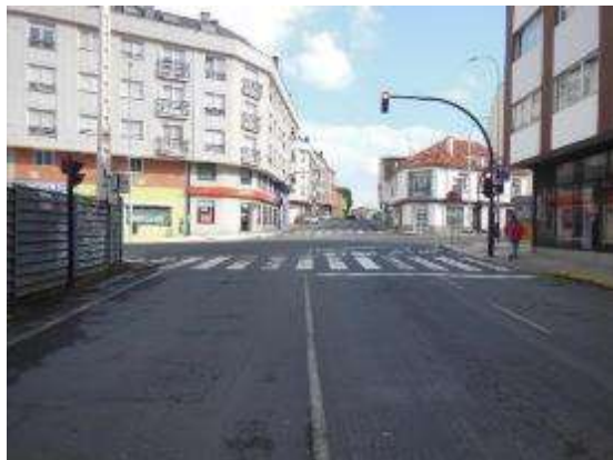
Foto 3. PK 2+130, incorporación semaforizada y señalización vertical y horizontal de STOP.
