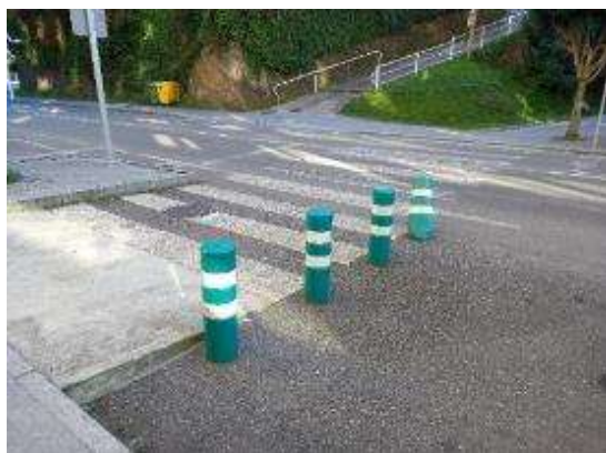
Foto 1. PK 84+550, sentido creciente. Paso de peatones.
