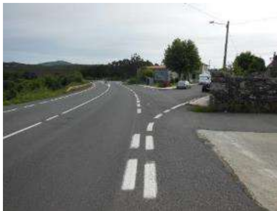
Foto 11. PK 74+930, sentido decreciente, incorporaciones.
