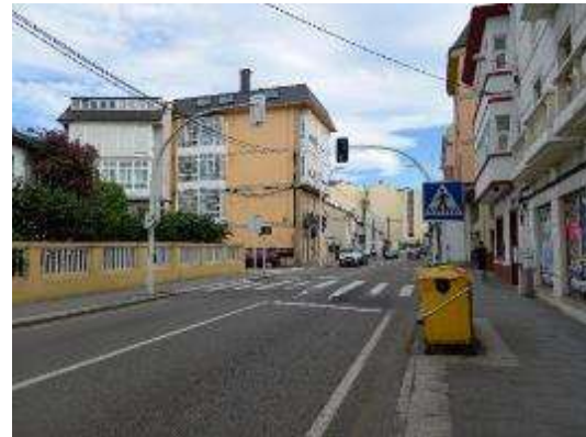
Foto 16. PK 83+830, sentido creciente, paso de peatones elevado, señalización horizontal desgastada.
