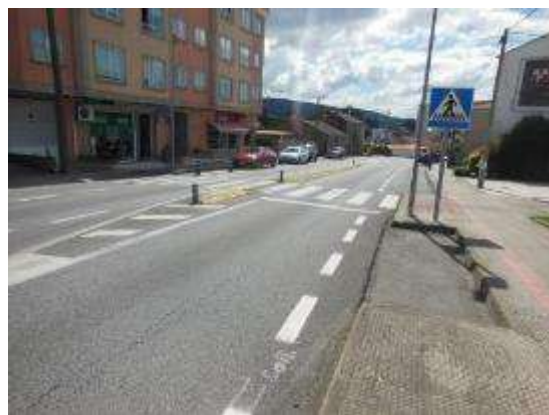
Foto 12. PK 8+890, sentido creciente. Paso de peatones con refugio central.
