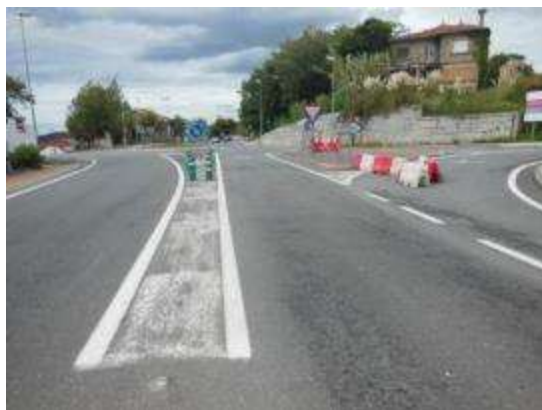
Foto 1. PK 11+520, sentido decreciente, vista general de la glorieta.
