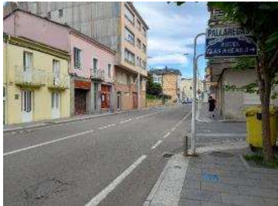
Foto 15. PK 83+770, sentido creciente, incorporación margen derecha sin señalización horizontal.
