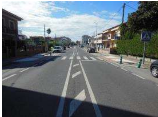
Foto 15. PK 9+170, sentido creciente, vista general.
