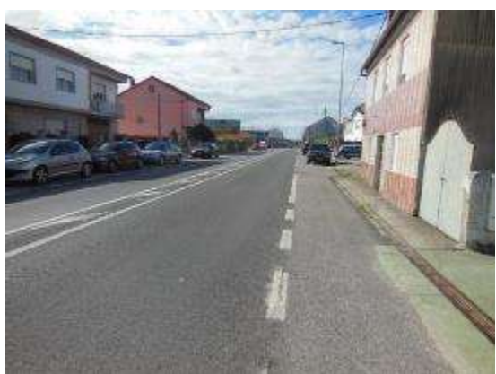
Foto 9. PK 8+770, sentido creciente, vista general.
