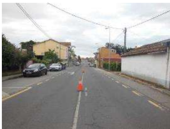
Foto 1. PK 3+900, sentido creciente. Vista general inicio del tramo, en obras en la actualidad.
