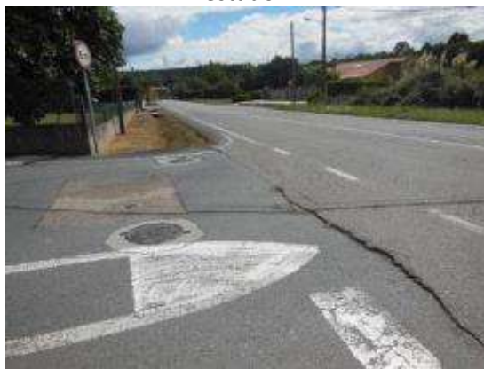
Foto 23. PK 3+900. Incorporación margen izquierdo hacia sentido creciente. Marcas viales en mal estado, grieta en el pavimento que genera un pequeño escalón.
