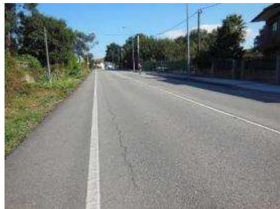
Foto 2. PK 10+600, sentido decreciente, vista general.
