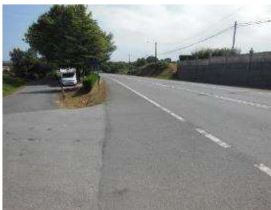
Foto 25. PK 23+970, sentido decreciente, vista general.
