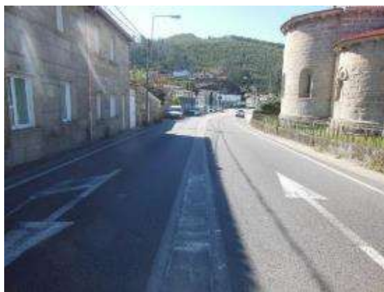
Foto 24. PK 2+940, sentido creciente. Vista general, marcas viales en mal estado.
