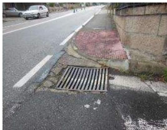
Foto 12. PK 1+620, incorporación margen derecho, sumidero en medio del paso de peatones.
