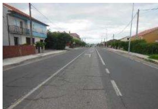
Foto 14. PK 4+740, sentido creciente, vista general. Carril central de espera para giro a la izquierda.
