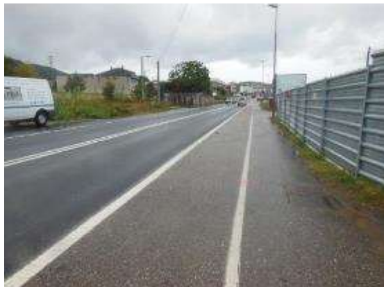
Foto 9. PK 2+510, sentido creciente. Sin diferenciación de itinerario peatonal.
