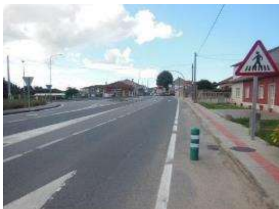
Foto 3. PK 8+430, sentido creciente, señal de peligro por peatones
