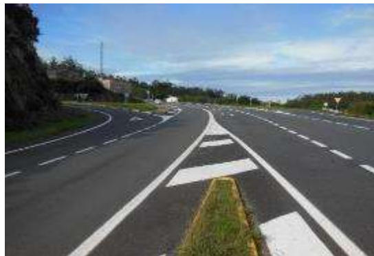
Foto 4. PK 74+700, creciente, intersección.
