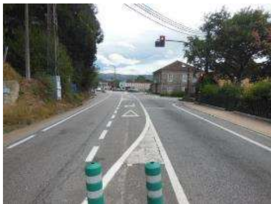
Foto 13. PK 18+230, sentido decreciente, vista general.
