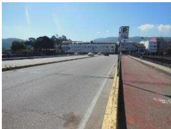
Foto 19. PK 12+860, sentido creciente, parada de autobús en medio del carril derecho de circulación.
