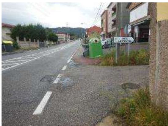
Foto 5. PK 1+490, sentido creciente, incorporación margen derecho sin señalización horizontal, existe señal de STOP.
