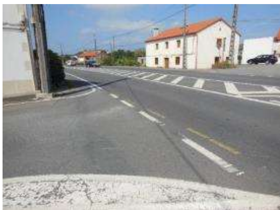
Foto 15. PK 23+420, sentido creciente, intersección margen izquierdo, escasa visibilidad.
