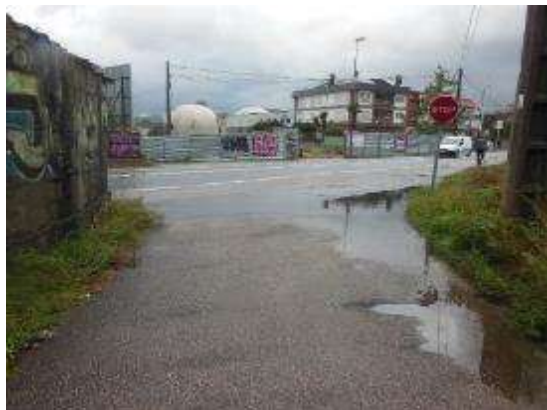
Foto 11. PK 2+550, incorporación margen izquierdo con señal de STOP. No existe señalización horizontal y visibilidad reducida en la incorporación.
