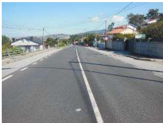
Foto 11. PK 11+890, sentido decreciente, vista general.
