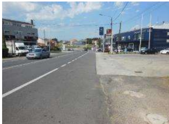
Foto 10. PK 29+210, sentido creciente, vista general del tramo, curva a la izquierda. Incorporación concesionarios.
