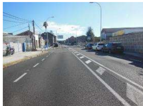
Foto 2. PK 1+000, sentido decreciente, vista general.
