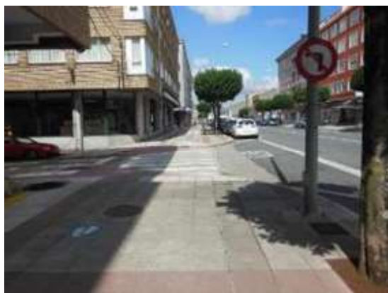
Foto 11. PK 3+960, incorporación margen derecha. Discontinuidad en el pavimento por diferencia de cota. Visibilidad reducida.
