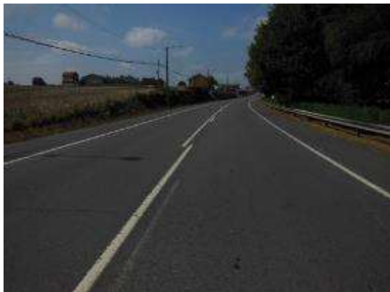
Foto 23. PK 23+820, sentido creciente, Vista general, inicio adelantamiento.
