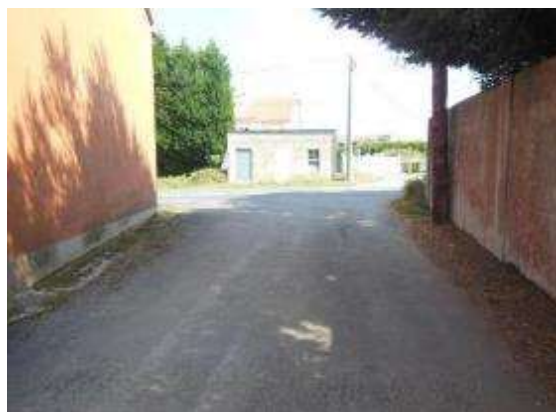
Foto 6. Incorporación margen izquierdo, PK 28+860, sin señal de STOP.
