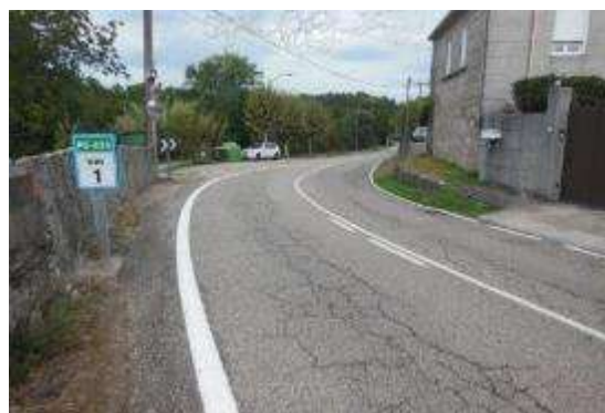
Foto 16. PK 1+000, sentido decreciente, curva cerrada a la derecha, existe un único panel direccional.
