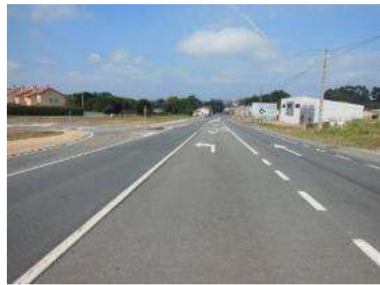
Foto 2. PK 22+850, sentido creciente, intersección margen izquierdo con carriles centrales de espera, aceleración y cambio de sentido.
