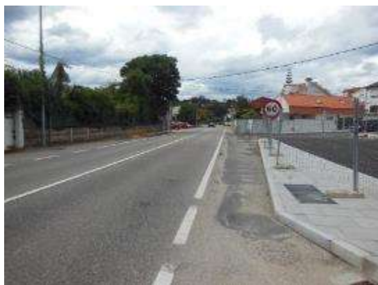
Foto 13. PK 12+350, sentido decreciente. Vista general.
