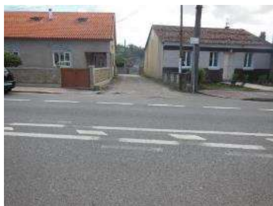
Foto 8. PK 8+630, acceso a viviendas margen izquierdo. Tacos en el cebreado central que permiten los giros a izquierda en ambos sentidos.
