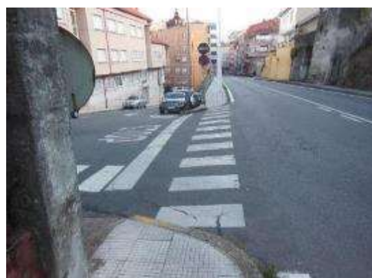
Foto 18. PK 1+160, incorporación margen derecho, visibilidad reducida por edificación de los peatones que cruzan el paso de peatones.
