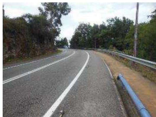
Foto 2. PK 4+570, sentido creciente, vista general.
