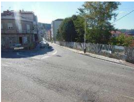
Foto 1. PK 0+000, sentido creciente, inicio del tramo, marcas viales desgastadas.
