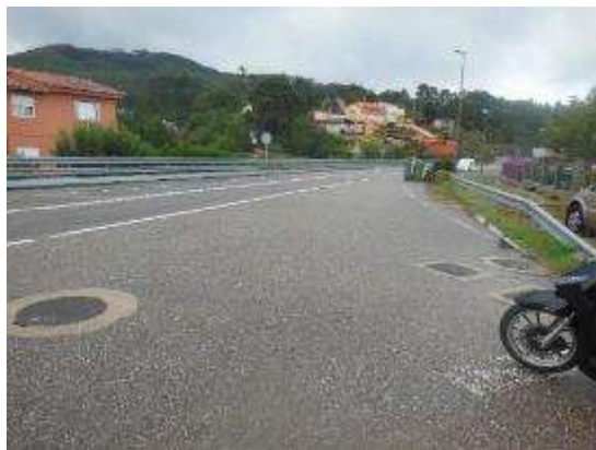
Foto 23. PK 3+450, incorporación margen derecho, vista hacia sentido creciente.
