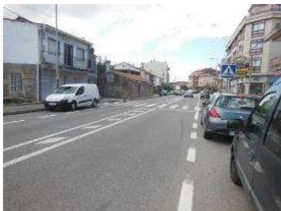
Foto 9. PK 8+640, sentido creciente, vehículos estacionados en ambos márgenes que reducen la visibilidad de peatones que crucen por el paso.
