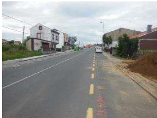
Foto 4. PK 4+100, sentido creciente, vista general.
