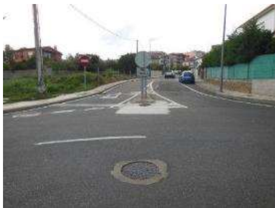
Foto 15. PK 12+440, ramal glorieta PO-552.
