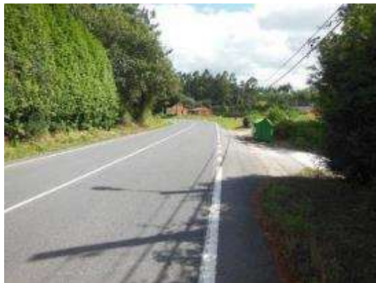
Foto 1. PK 2+840, sentido creciente. Curva pronunciada a la izquierda, se pierde la visibilidad del trazado.
