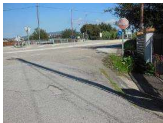
Foto 26. PK 13+830, incorporación margen izquierdo. Señal de STOP en mal estado, sin señalización horizontal. Discontinuidad en el pavimento.
