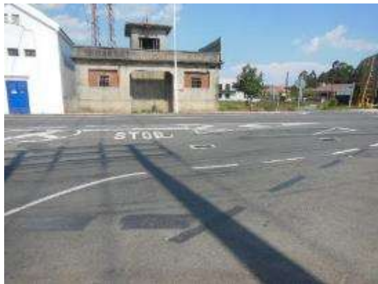
Foto 15. PK 29+740. Vista general, incorporación margen izquierdo, cruce.
