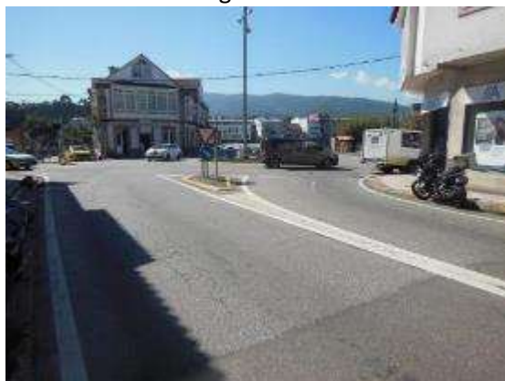
Foto 17. PK 12+780, vista hacia sentido creciente, glorieta. Marcas viales desgastadas y señalización horizontal de ceda en mal estado.
