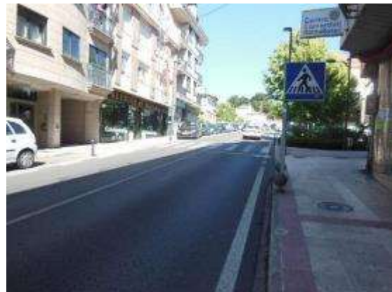
Foto 16. PK 12+690, sentido decreciente, paso de peatones desgastado.
