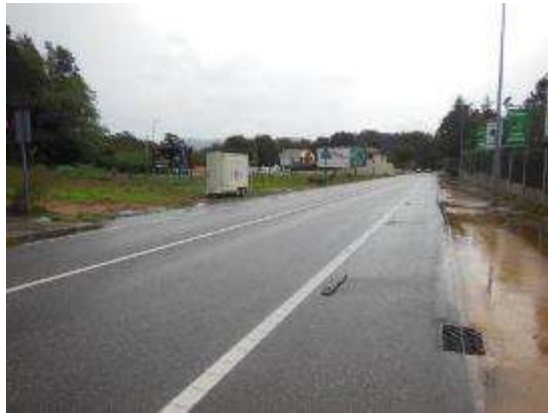
Foto 21. PK 12+820, sentido creciente, vista general.
