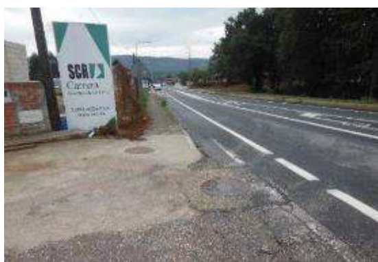
Foto 19. PK 2+200, incorporación margen derecho, vista hacia sentido decreciente. No existe señalización.
