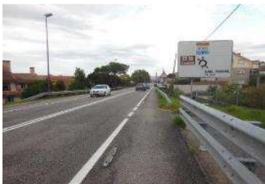
Foto 17. PK 5+380, sentido decreciente, vista general.
