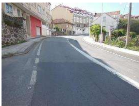
Foto 7. PK 10+430, sentido creciente, curva cerrada a la derecha, se pierde la visibilidad del trazado.
