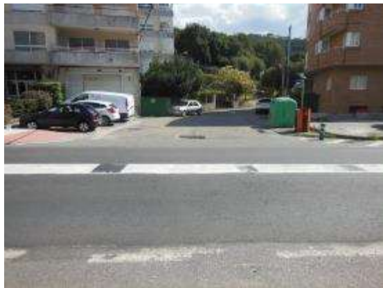
Foto 5. PK 10+350, incorporación margen izquierdo sin señalizar.
