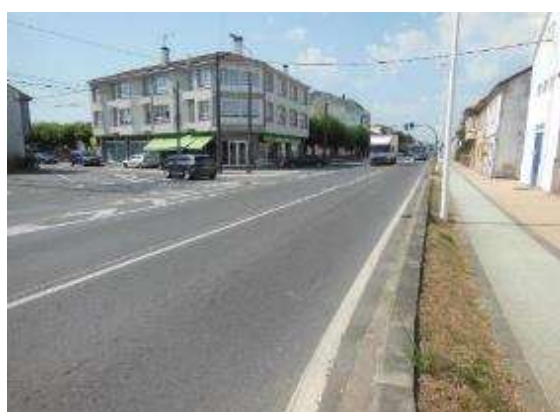
Foto 14. PK 29+720, sentido creciente, vista general, incorporación margen izquierdo, acceso a viviendas.
