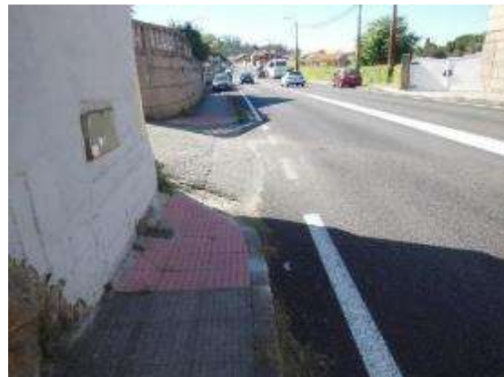
Foto 28. PK 2+480, vista hacia sentido creciente. Incorporación margen izquierdo sin señalización, no existe paso de peatones que dé continuidad a la acera.
