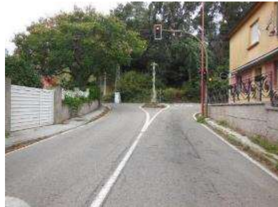
Foto 10. PK 18+200, incorporación semaforizada margen izquierdo. Señalización horizontal de STOP antes de la intersección. Cambio de rasante. Existe un cruceiro en medio de ambos carriles.
