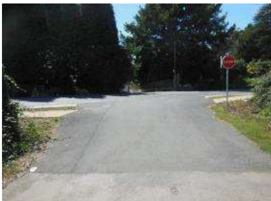
Foto 11. PK 3+390. Incorporación margen izquierdo con señal STOP.
