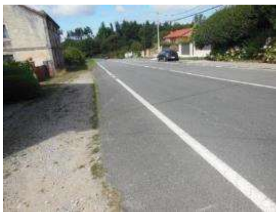
Foto 17. PK 3+750. Accesos a propiedades margen derecho, cambio en el tipo de pavimento.
