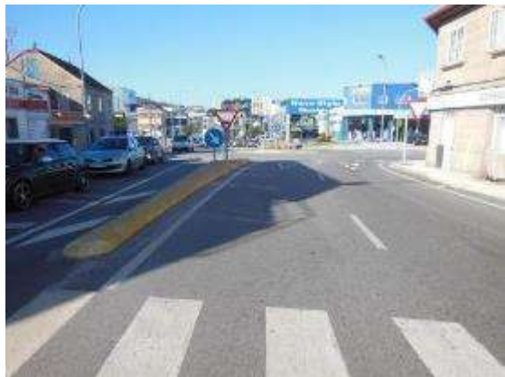
Foto 5. PK 1+100, sentido creciente, vista general glorieta.
