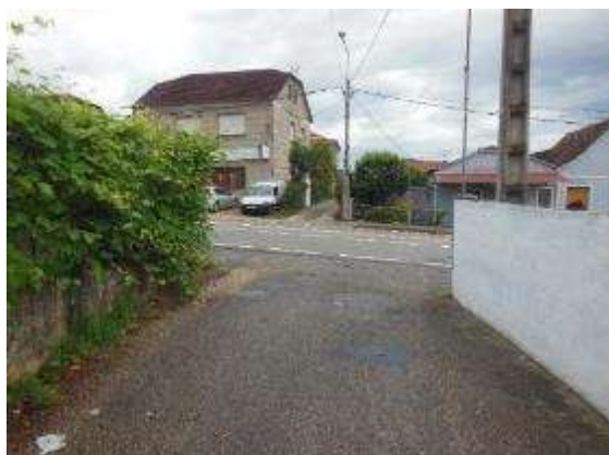
Foto 11. PK 1+720, incorporación margen izquierdo sin señalizar.
