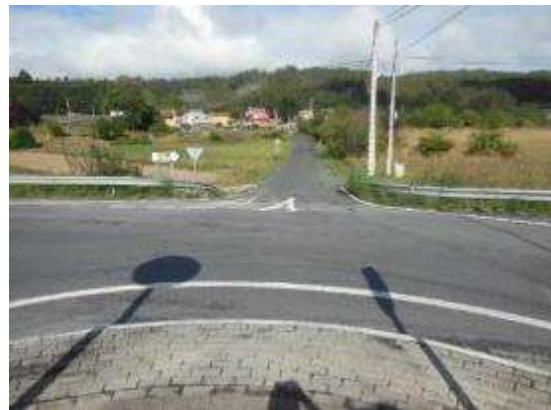
Foto 20. PK 1+360 glorieta. Ramal a la DP-3102 Ledoño, cambio de rasante.
