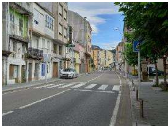
Foto 13. PK 83+740, sentido creciente. Señal de paso de peatones oculta por vegetación.
