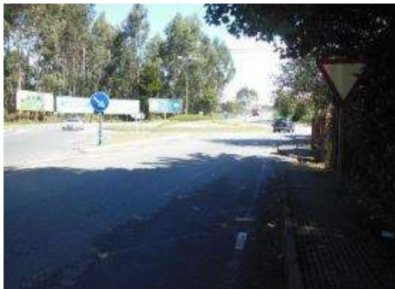
Foto 16. PK 3+600, sentido creciente. Entrada rotonda, señal de ceda el paso antigua y un poco oculta por la vegetación.
