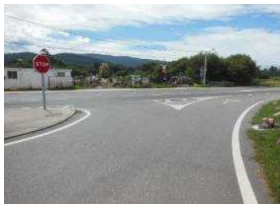
Foto 22. PK 18+850, intersección. Señalización horizontal de STOP muy desgastada (inapreciable).
