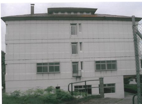
Fachada lateral izquierda
