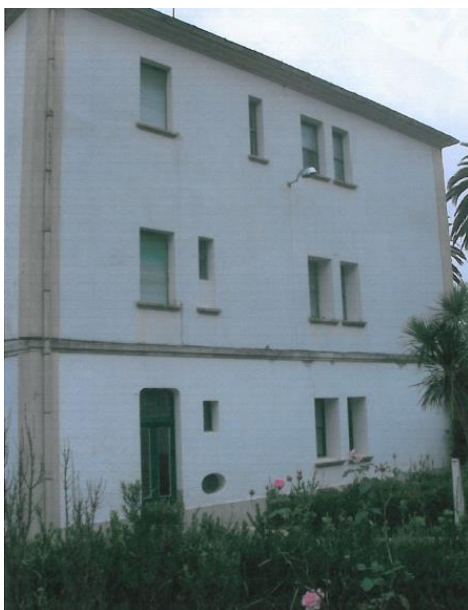
Fachada lateral esquerda
