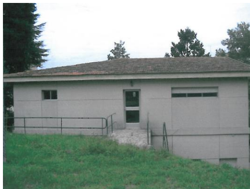
Fachada lateral izquierda
