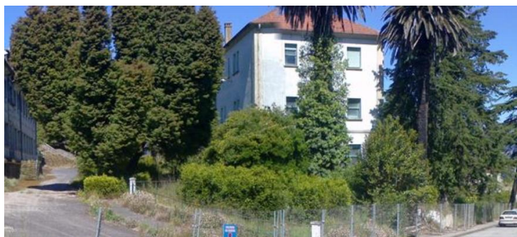
Elementos nº 35, 36 e 37
