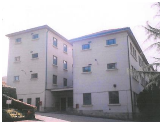
Fachada lateral izquierda
