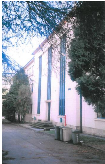
Fachada principal, vista 1
