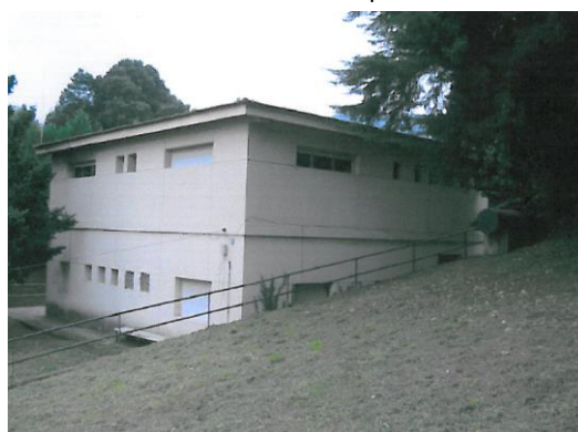
Fachada posterior y lateral derecha
