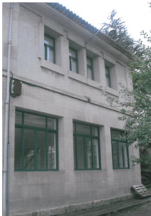
Fachada lateral izquierda
