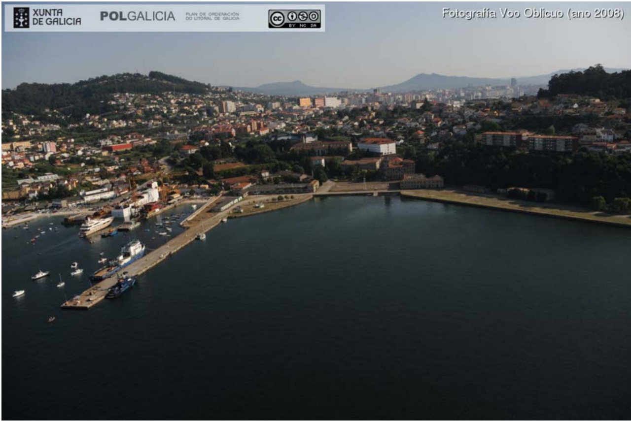
FOTO 59 (Estado previo á execución do PS-5)
