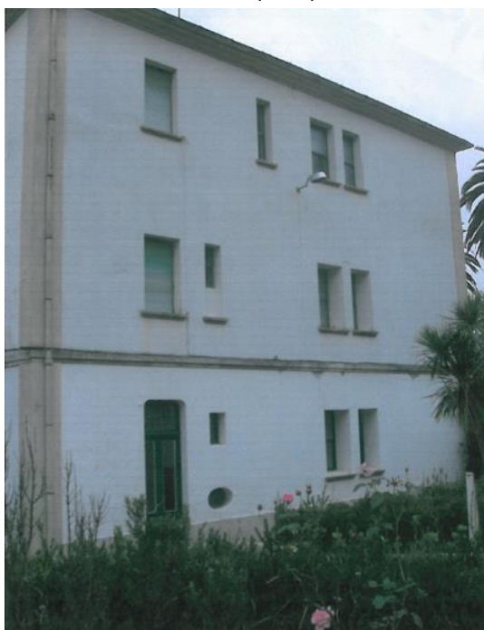
Fachada lateral izquierda
