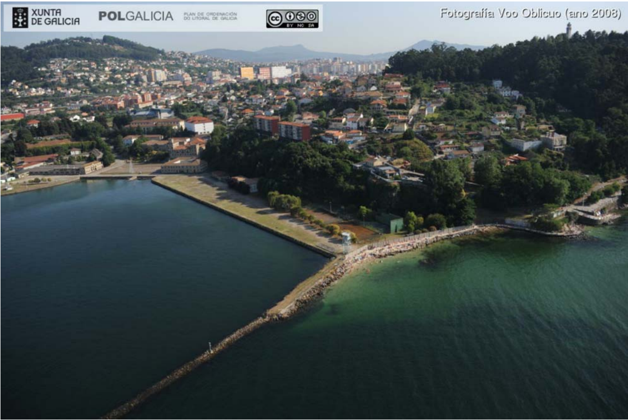
FOTO 60 (Estado previo á execución do PS-5)
