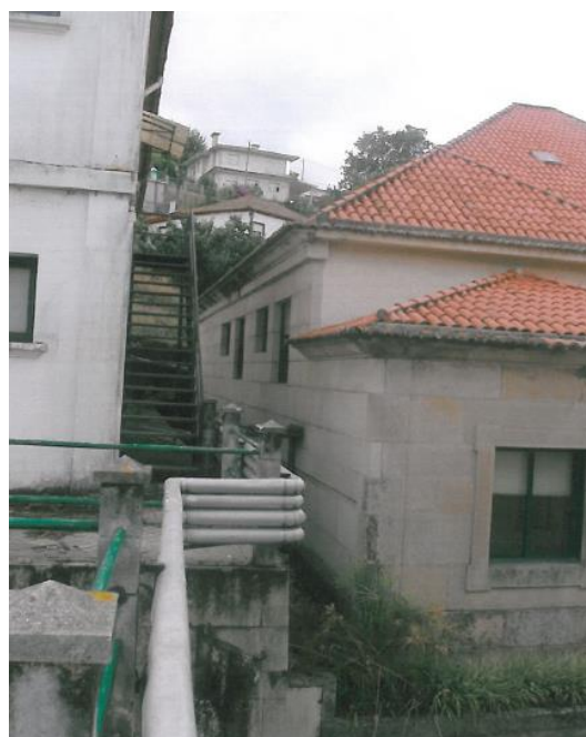
Fachada lateral izquierda
