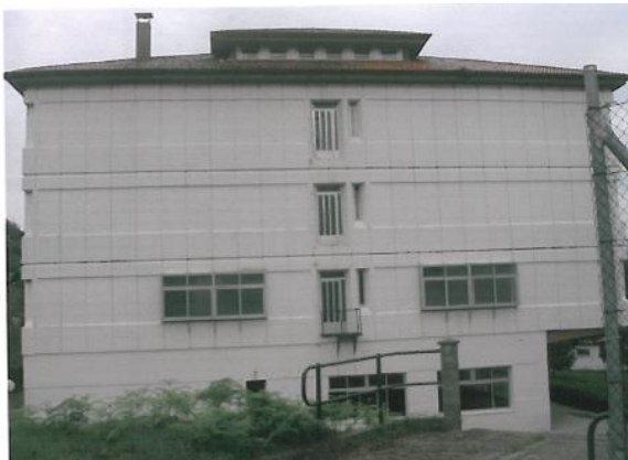
Fachada lateral esquerda
