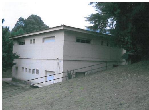
Fachada posterior e lateral dereita
