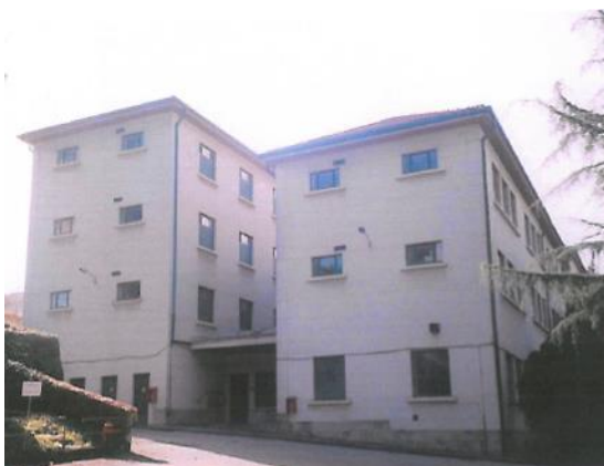
Fachada lateral esquerda
