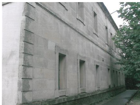
Fachada lateral esquerda
