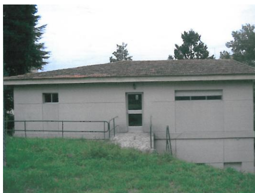
Fachada lateral esquerda
