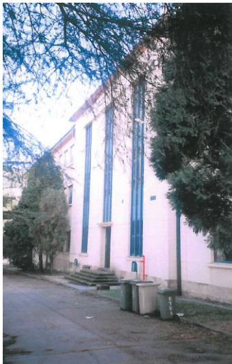
Fachada principal, vista 1
