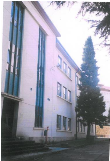
Fachada principal, vista 2
