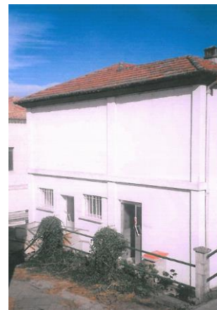
Fachada lateral esquerda
