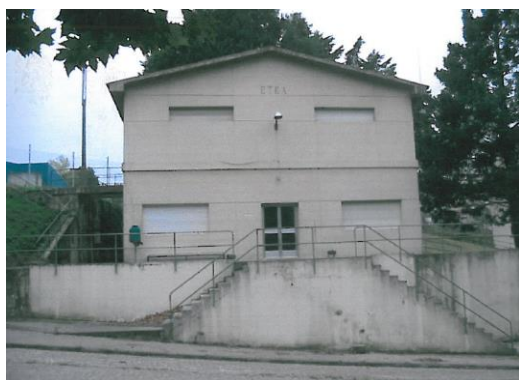
Fachada principal e acceso dende Avenida Central
