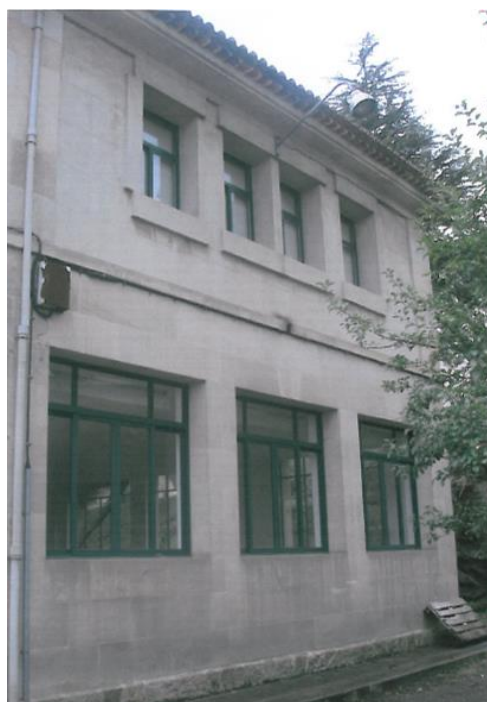
Fachada lateral esquerda
