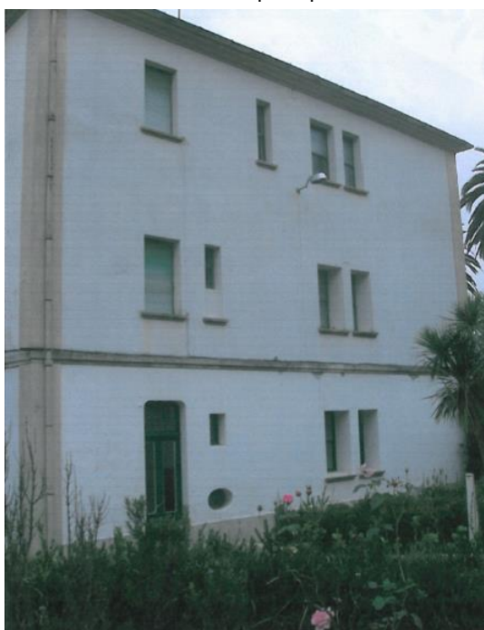
Fachada lateral esquerda
