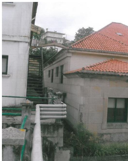
Fachada lateral esquerda
