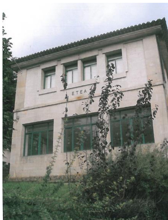
Fachada lateral esquerda
