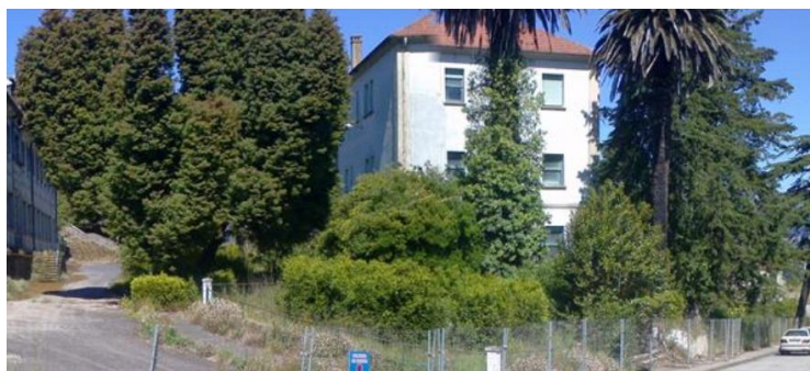
Elementos nº 35, 36 e 37
