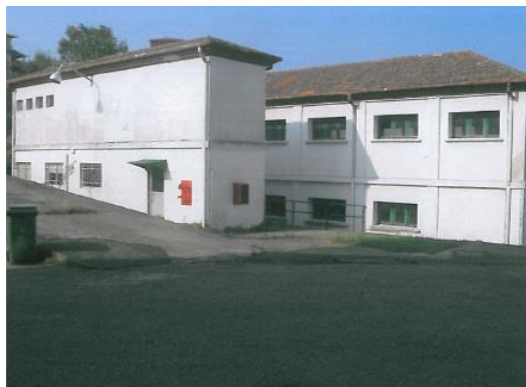
Fachada lateral esquerda
