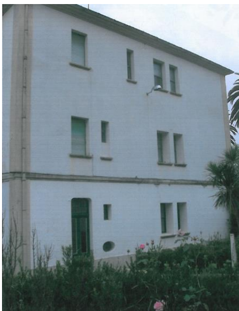
Fachada lateral esquerda
