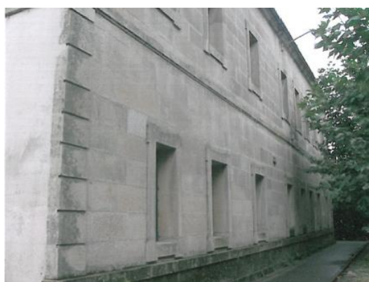
Fachada lateral esquerda
