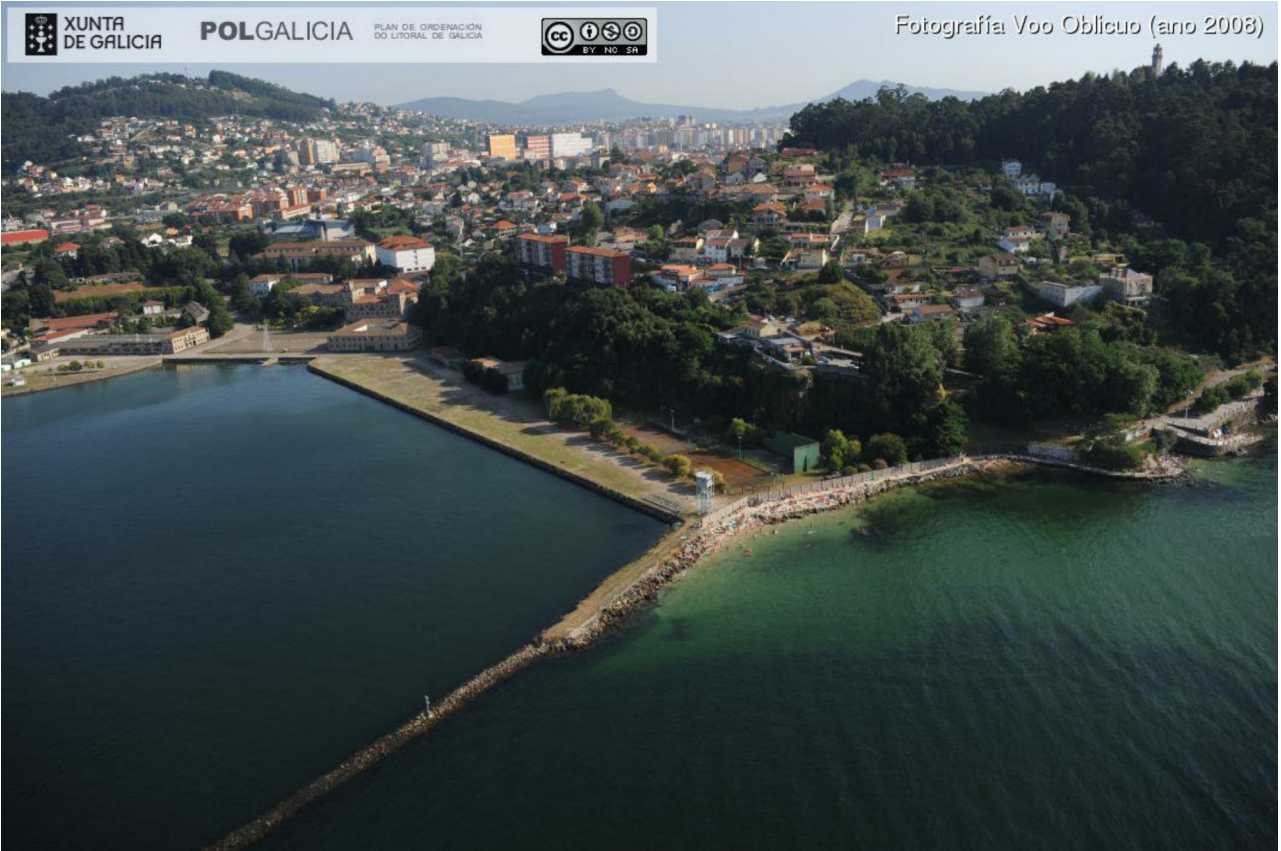
FOTO 33 (Estado previo á execución do PS-5)
