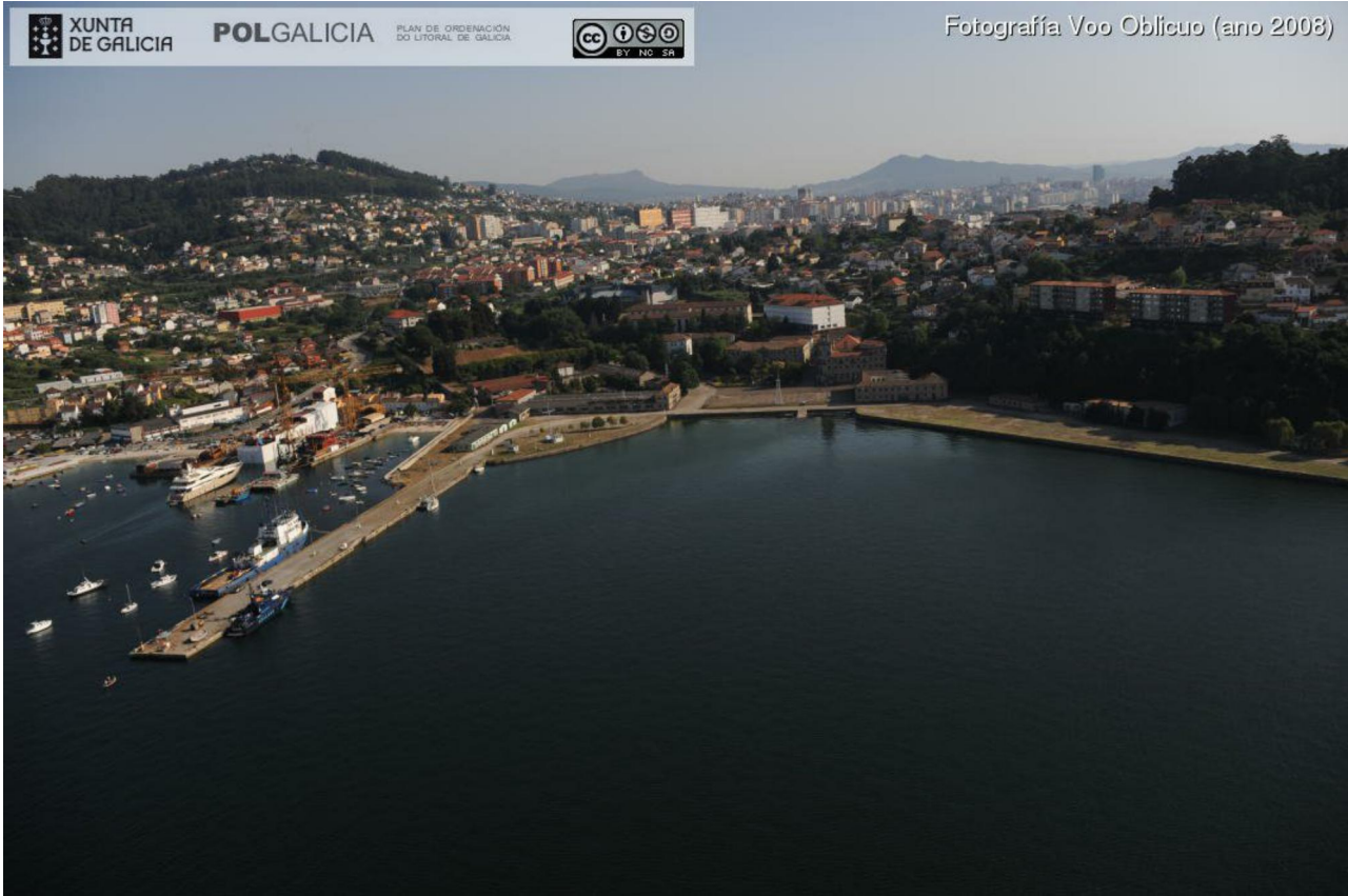
FOTO 32 (Estado previo á execución do PS-5)
