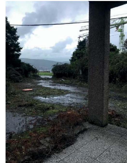
Vial existente. Vista hacia el mar
