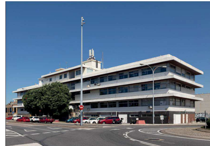
Vista do actual edificio en Bouzas (Vigo) que alberga ao IIM
