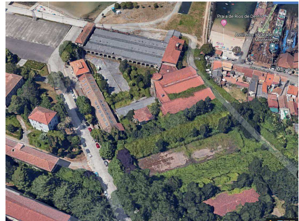
Vista aérea. Conexións viarias
