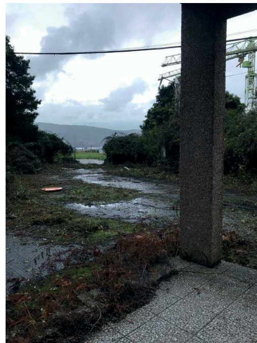
Vial existente. Vista cara ao mar
