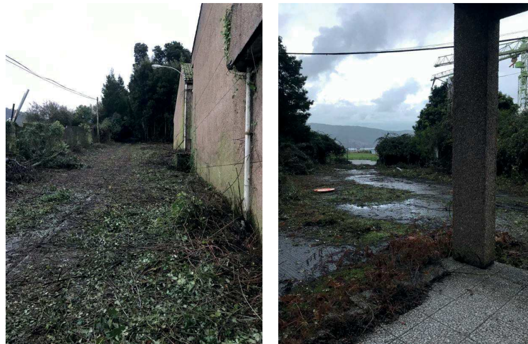
Vial existente. Vista cara ao Sur
