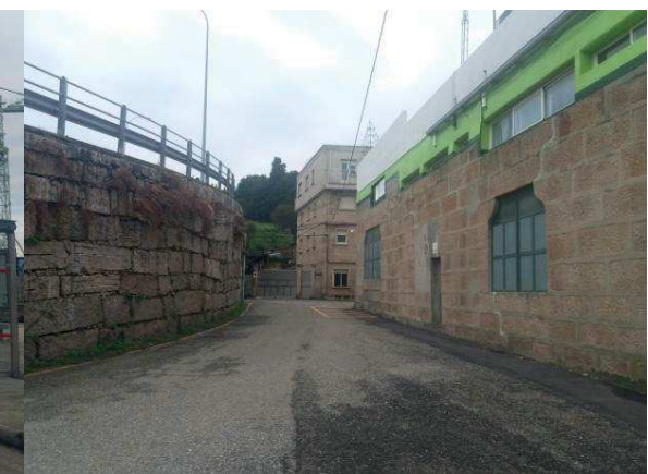
Paso entre a avenida e o estaleiro
